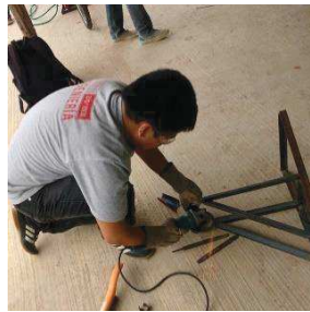
Figura 10. Construcción de la base.
