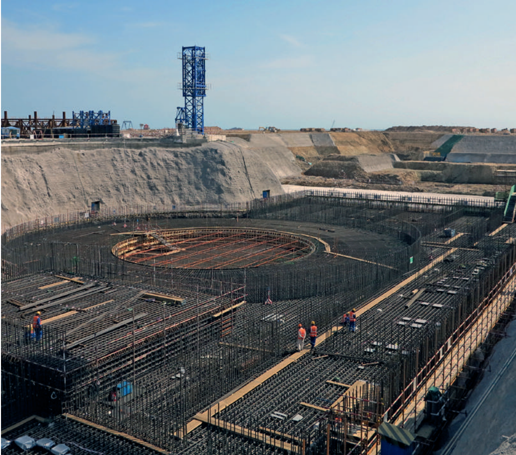
Central nuclear en construcción en China.
