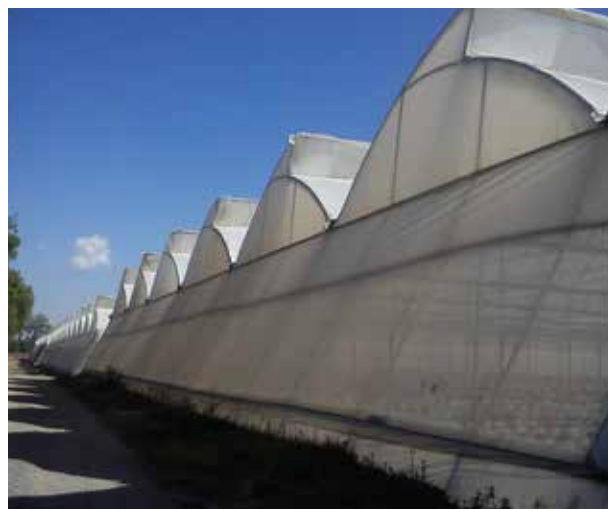
Invernadero con cubiertas plásticas y mallas antiáridos.
