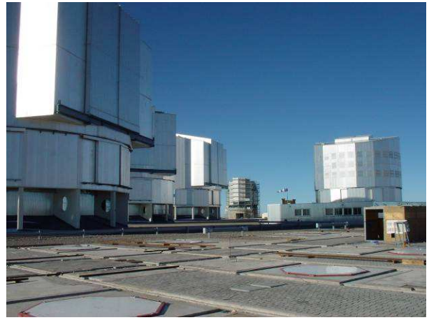
Los cuatro cúpulas del Very Large Telescope del Observatorio Europeo Austral (ESO), instaladas en Paranal en Chile. Cada cúpula contiene un telescopio de 8.20 m de diámetro. © DP
