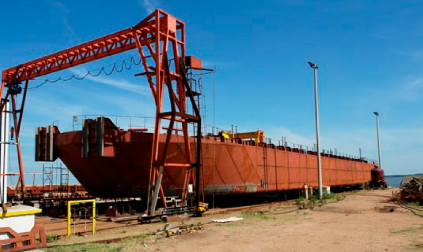
Construcción de una barcaza cisterna para ANCAP en el astillero de la Armada Nacional
