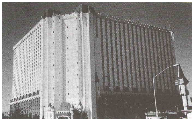
Fig. 1.25 – Hotel Excalibur em Las Vegas (zona sísmica moderada) alvenaria armada
