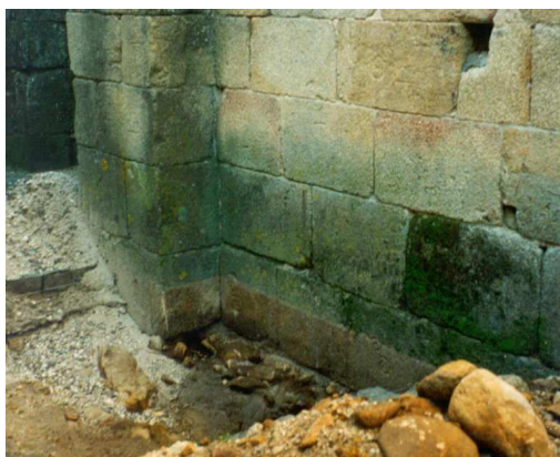
e) Fundação directa de parede no afloramento rochoso
