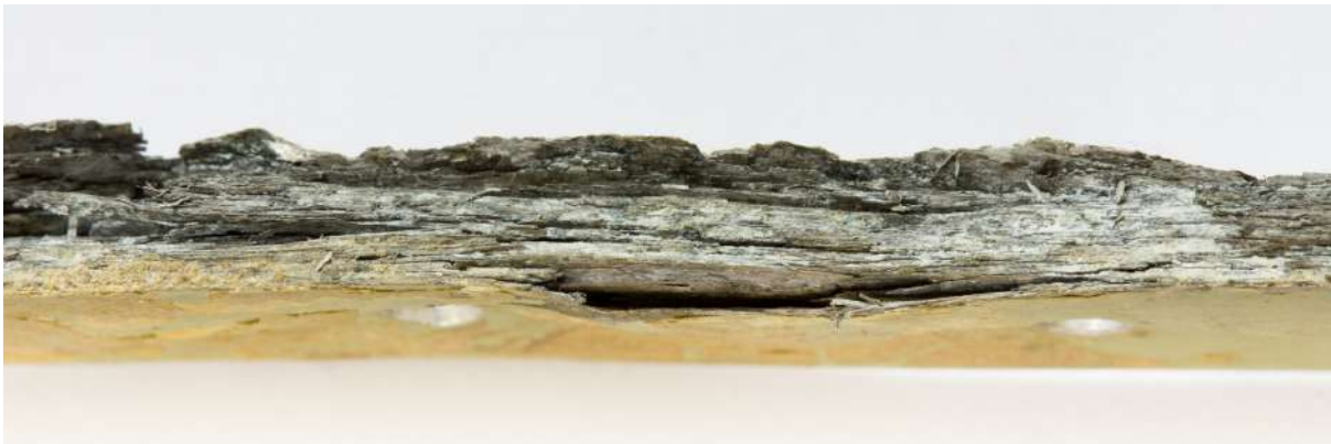
Ilustración 63: Corrosión por exfoliación, fuente: Wikimedia Commons
