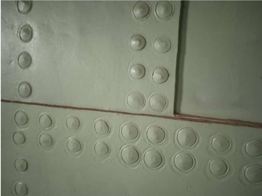
Ilustración 102: Remachado en paralelo, vapor LA PALMA ; Fuente: elaboración propia.
