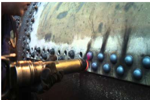
Ilustración 92: martillo neumático en proceso de remachado; Fuente: i.ytimg.com
