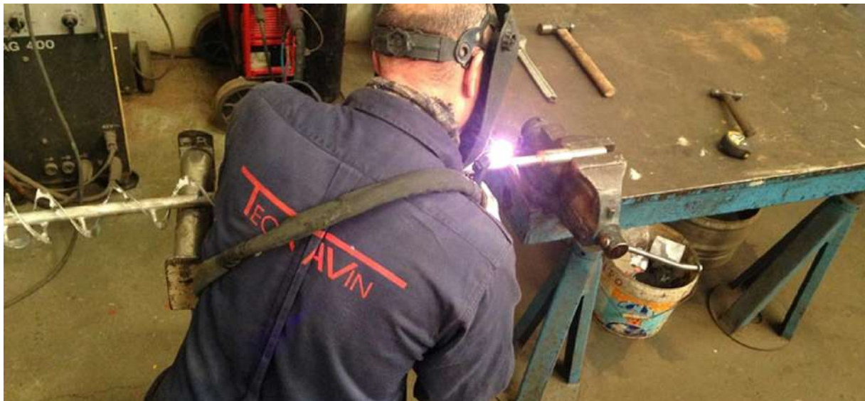
Ilustración 118: Trabajo de soldadura por Tecnavin, Fuente: tecnavin.es
