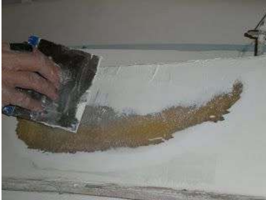
Ilustración 140: Aplicación de material de relleno, Fuente: Semirrigidasonline.es
