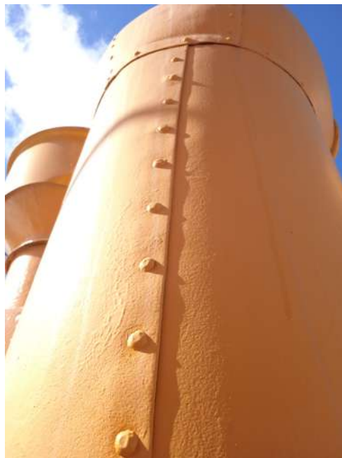
Ilustración 95: Remachado por recubrimiento, vapor LA PALMA ; Fuente: elaboración propia.
