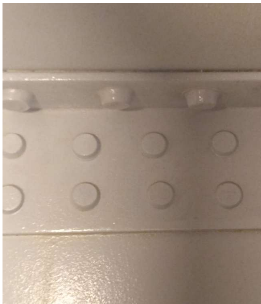
Ilustración 97: Remachado a simple cubrejunta, vapor LA PALMA ; Fuente: elaboración propia.
