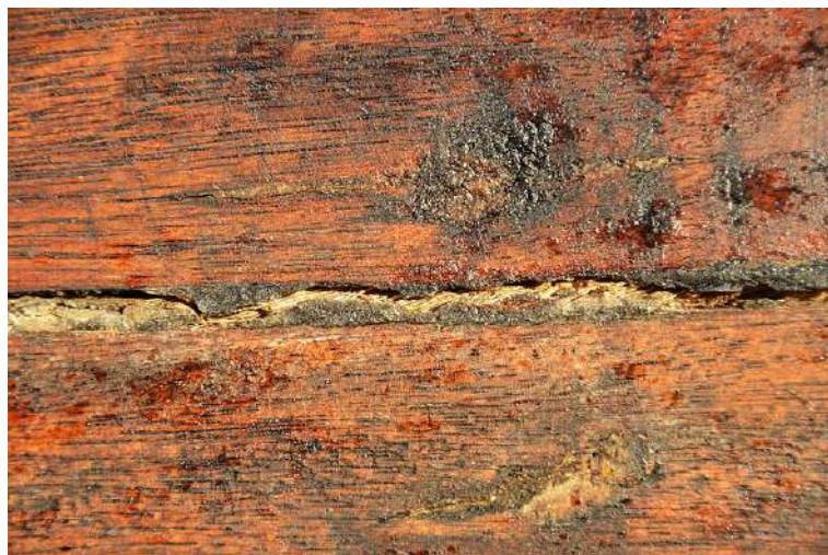
Ilustración 12: Junta calafateada, Fuente: commons.wikimedia.org
