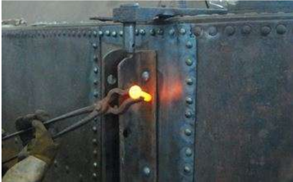
Ilustración 91: introducción de remache en su ubicación correspondiente ; Fuente: goebelfasteners.com
