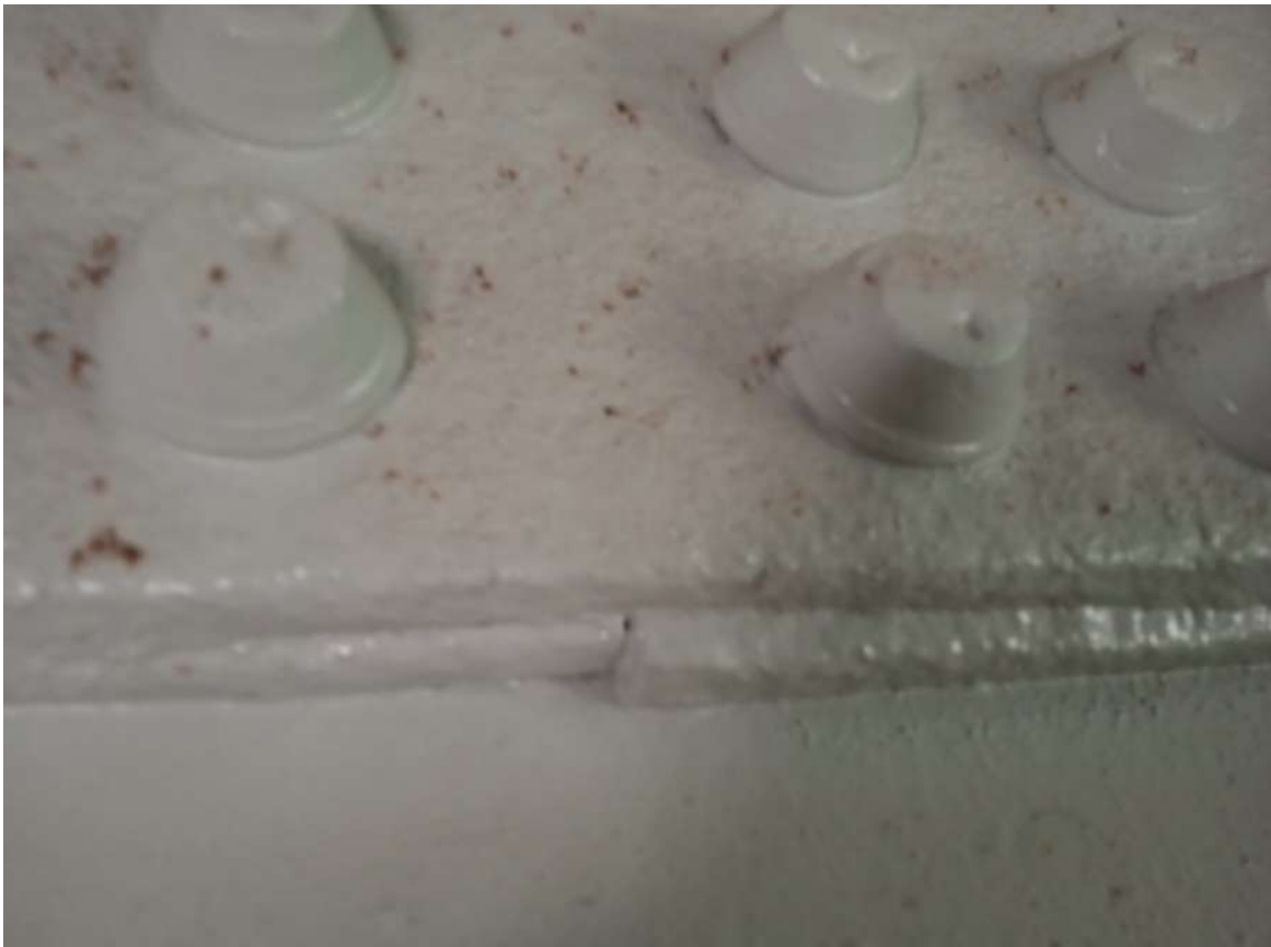
Ilustración 99: Remachado a doble cubrejunta, vapor LA PALMA ; Fuente: elaboración propia.
