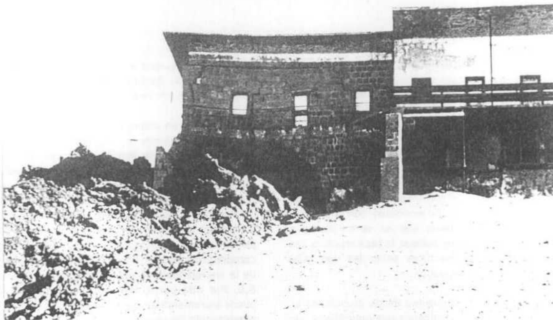
Fig. 16-III.1.- Instalaciones turísticas destruidas por una colada en las faldas del Etna. Foto V.Araña
