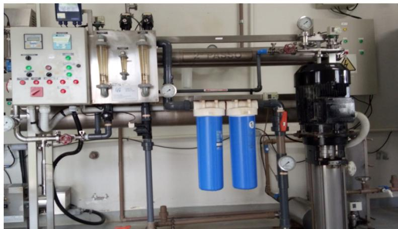
**Figura 2.** Sistema de Osmose Reversa. Fonte: autor (2017).
