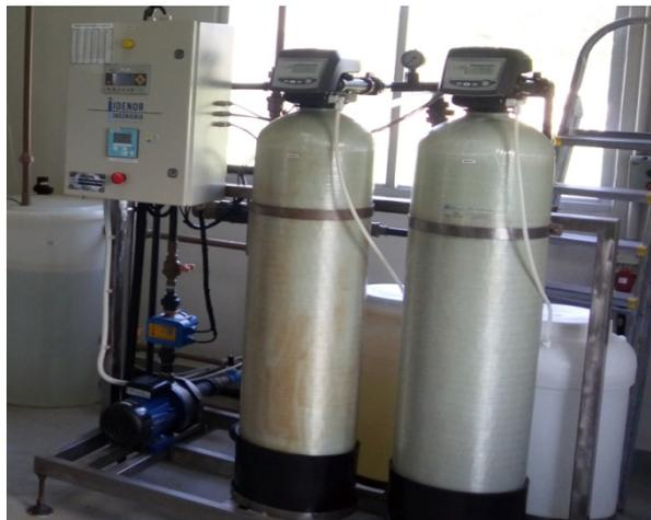
**Figura 1.** Sistema Deionizador. Fonte: autor (2017).
