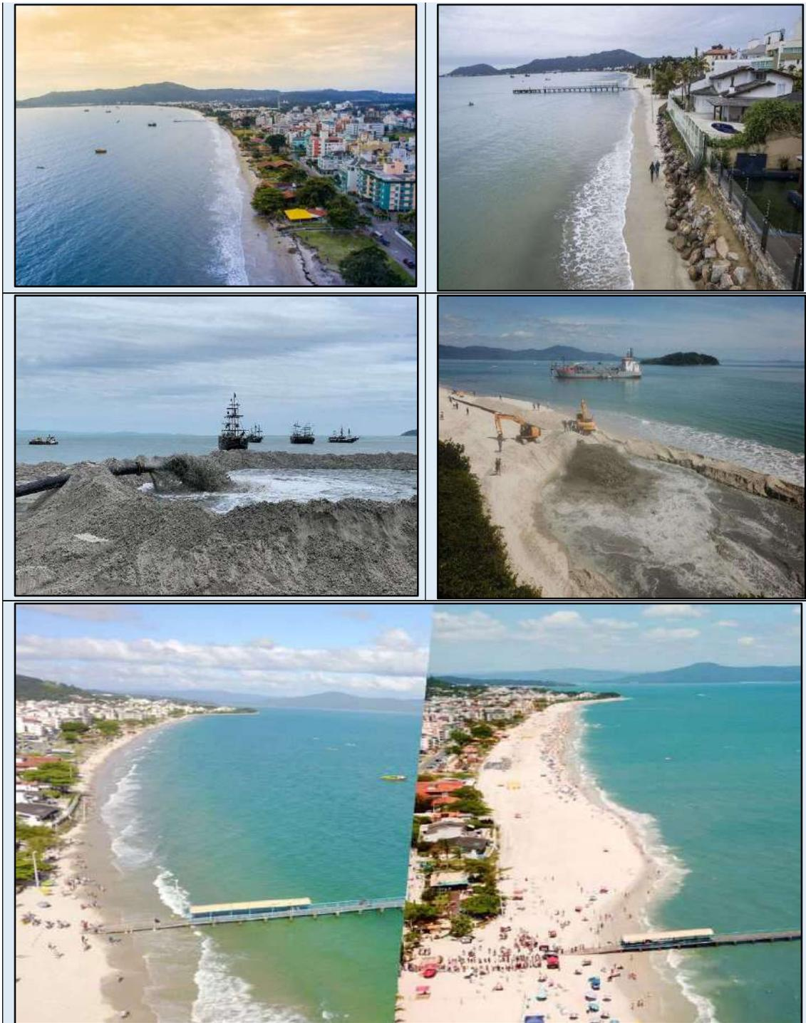
**Figura 93.** Alargamento da faixa de areia ou alimentação/engordamento artificial da praia de Canasvieiras, ilha de Santa Catarina/SC, Brasil. As duas imagens superiores mostram a praia antes do engordamento, as duas imagens centrais mostram a técnica utilizada com implantação de Depósito tecnogênico dragado num montante de 350.000m<sup>3</sup> de areia de uma jazida submarina localizada à 1km à nordeste da praia erodida, a imagem inferior mostra a praia recuperada no final de 2019.
