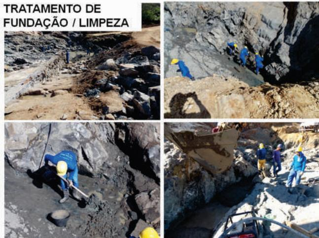
**Figura 8.** Tratamento de discontinuidades, não detectadas na campanha de investigação geotécnica. Aumento nos custos de tratamento da fundação.
