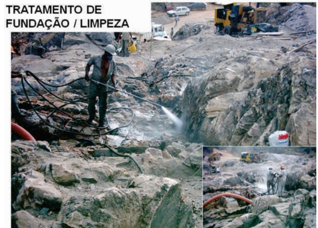
**Figura 5.** Tratamento / limpeza de fundação.
