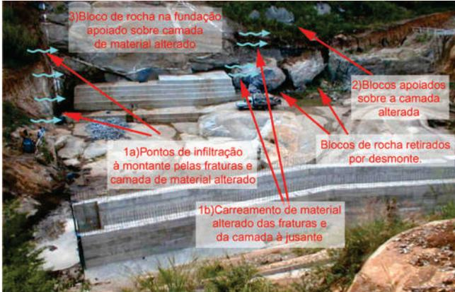
**Figura 3.** Barragem de Camará. Reforço de fundação. Solução adotada (cortesia: Andrade Galvão Ltda)
