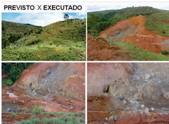
**Figura 9.** Previsto topo rochoso próximo a superfície. Escavação revelou topo rochoso em profundidade e em rocha incompetente, fraturada e alterada.
