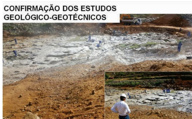
Figura 2. Limpeza e preparo de fundação.
