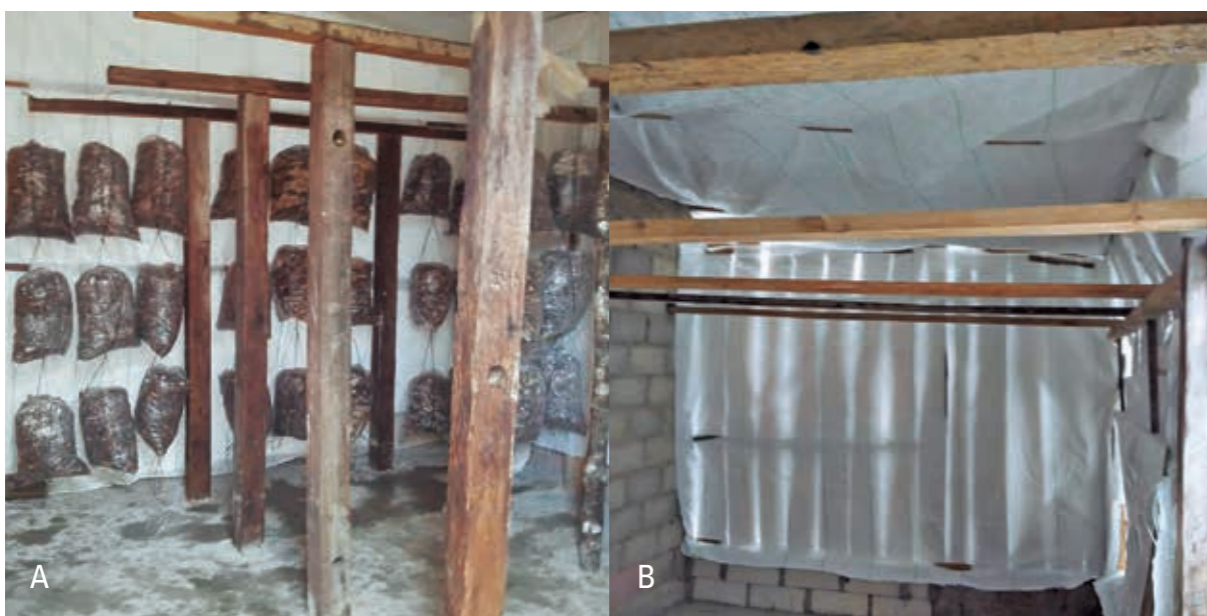
Imagen 20: Sala de cultivo construida con bloques de hormigón y piso alisado (a), paredes y techo cubierto con plástico (b).
