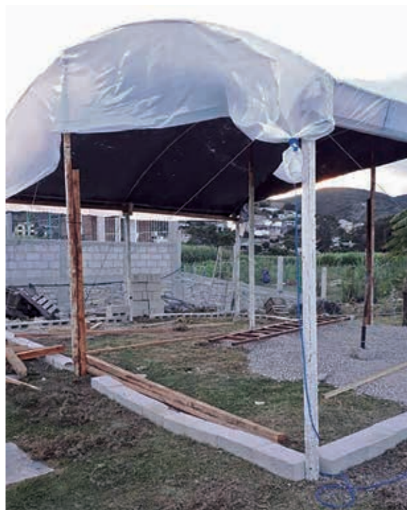
Imagen 23: Proceso de construcción de sala de cultivo. Estructura de madera y piso con una capa de piedra. Techo de media sombra y paredes de plástico.
