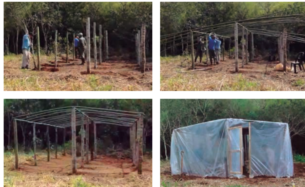
Imagen 21: Proceso de construcción de sala de cultivo. Estructura de troncos y bambú. Techo cubierto con media sombra y paredes de plástico.
