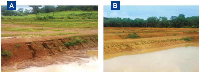
Figura 20. Talude de viveiros sem cobertura vegetal erodido pela chuva (A) e talude com plantio de grama-batatais em fase inicial de vegetação (B). Fotos: Fabrício P. Rezende.
