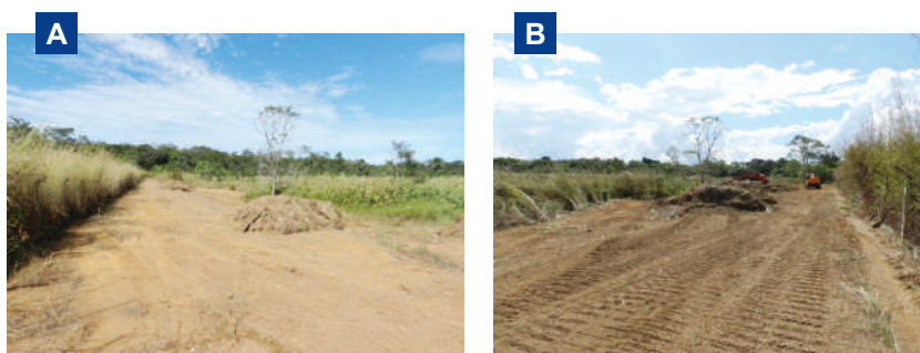
Figura 8. Preparo da área, com decapagem do material vegetal da camada superior do solo. Fotos: Giovani T. Bergamin.
