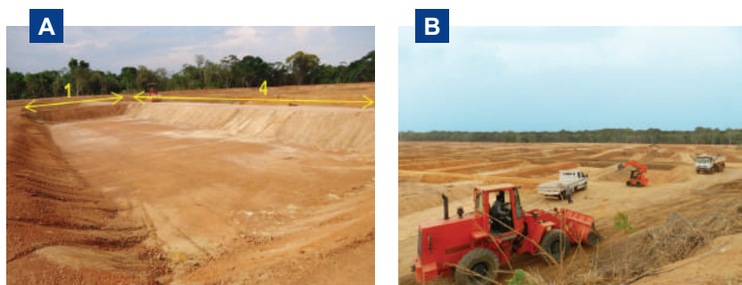
Figura 2. Proporção ideal entre largura e comprimento (1:4) dos viveiros (A); Máquinas trabalhando na construção de viveiros (B). Fotos: (A) Fabrício P. Rezende; (B) Giovani T. Bergamin.
