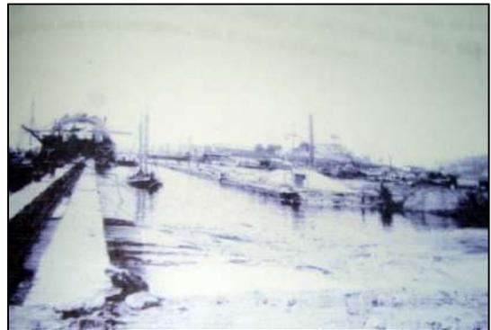
**Figura 6.** A delimitação da área aterrada, com parte da linha inicial do cais. Ao fundo, o maquinário empregado nas fundações da muralha do cais (1910) (IN: C/SUBPC/CCPE, 2009).
