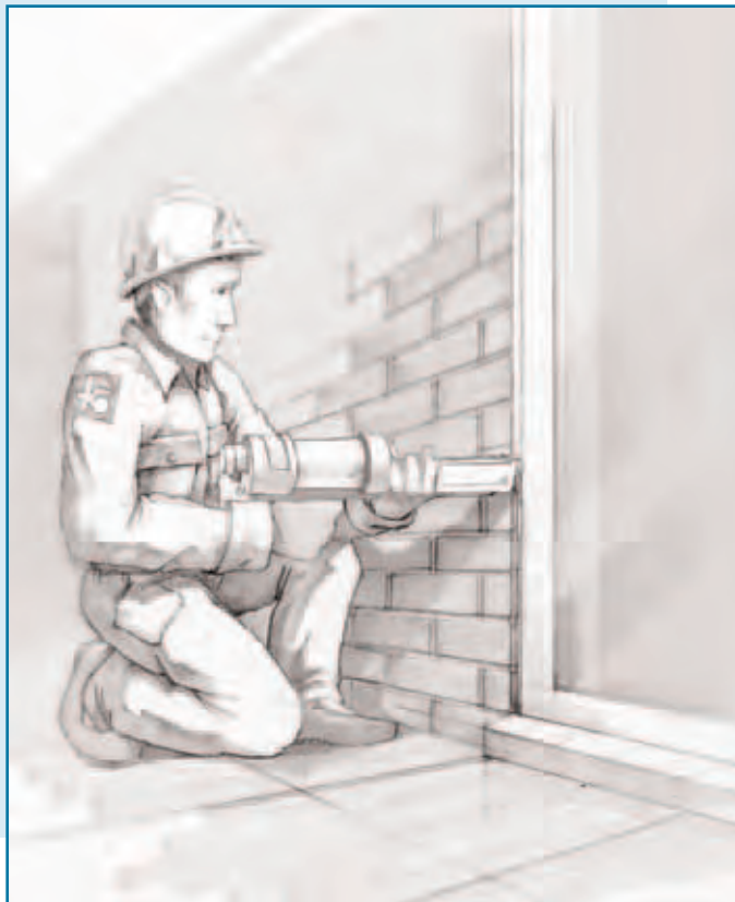
Una vez fijada la ventana al muro, se procederá a la colocación de remates y sellado de la ventana. Lo habitual es rematar las juntas exteriores con un cordón de silicona neutra.
