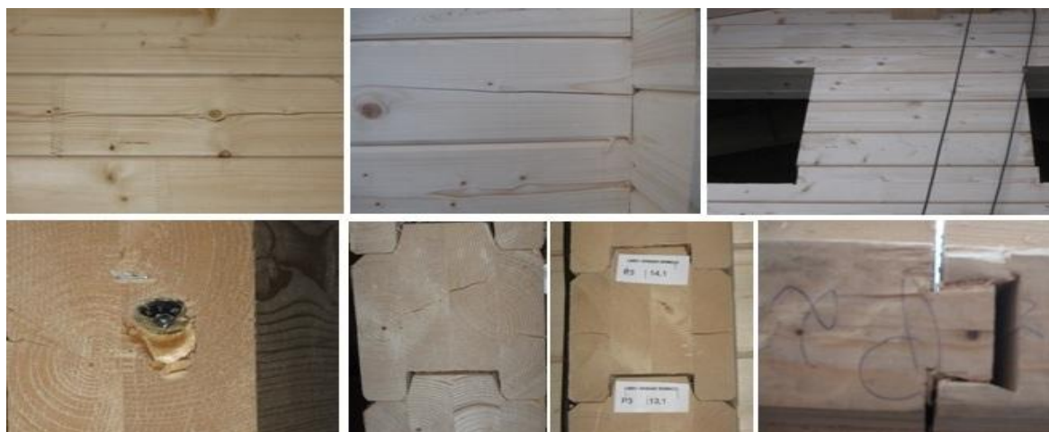
Figura 13 – Danos observados no ensaio.
