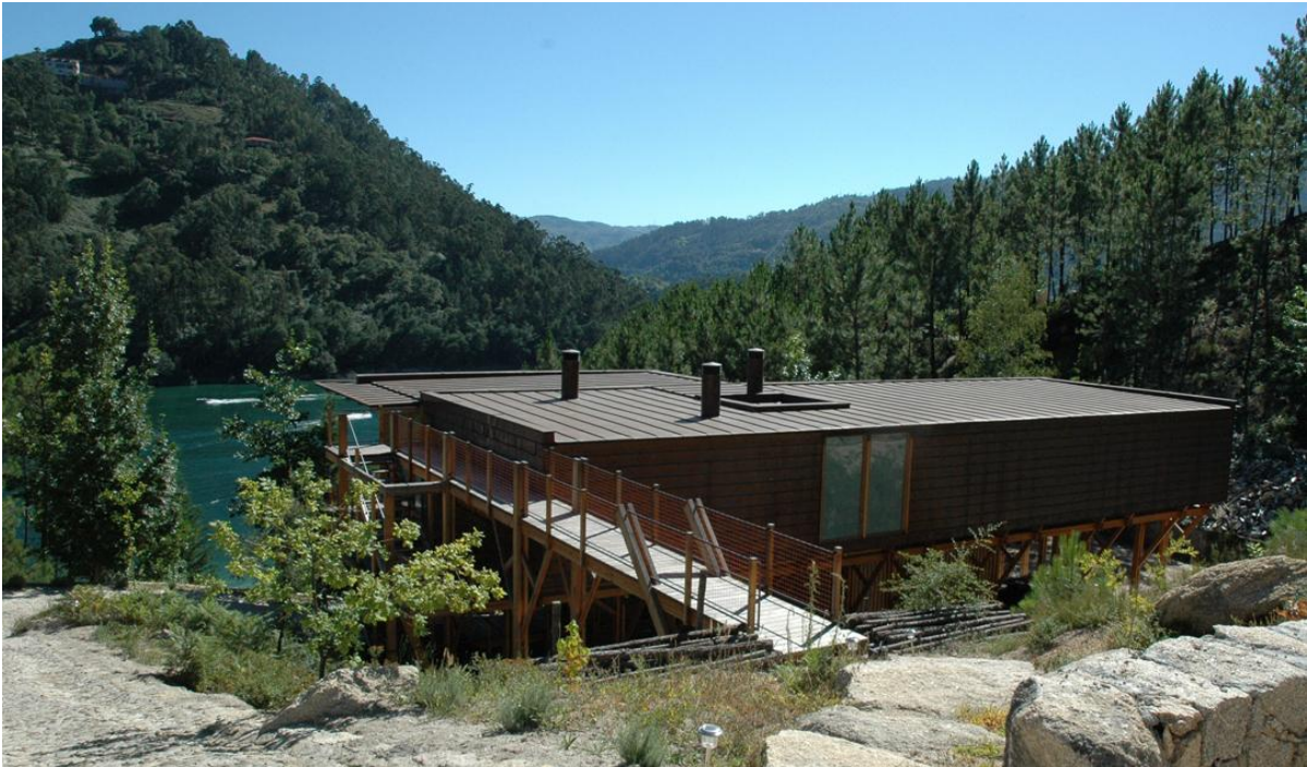
Figura 3 – Ponte de acesso pedonal pela cota da cobertura.
