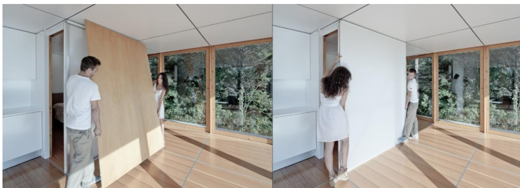
Figura 7 – A flexibilidade das paredes internas da MIMA – posição e material.
