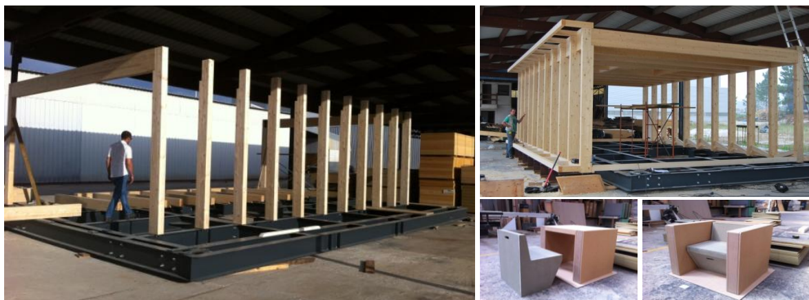
Figura 23 – Fotos da construção do protótipo em Viana.
