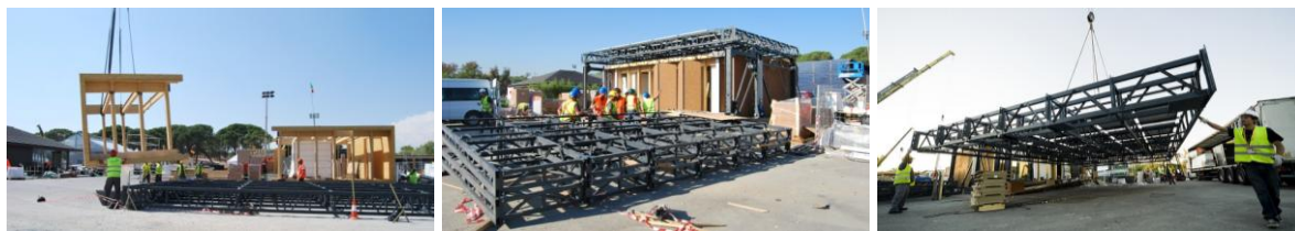
Figura 24 – Fotos do início de construção do protótipo na Vila Solar em Madrid.
