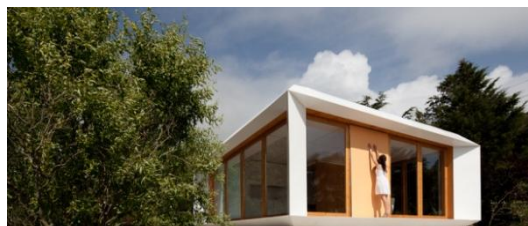
Figura 8 – A flexibilidade das paredes externas da MIMA.
