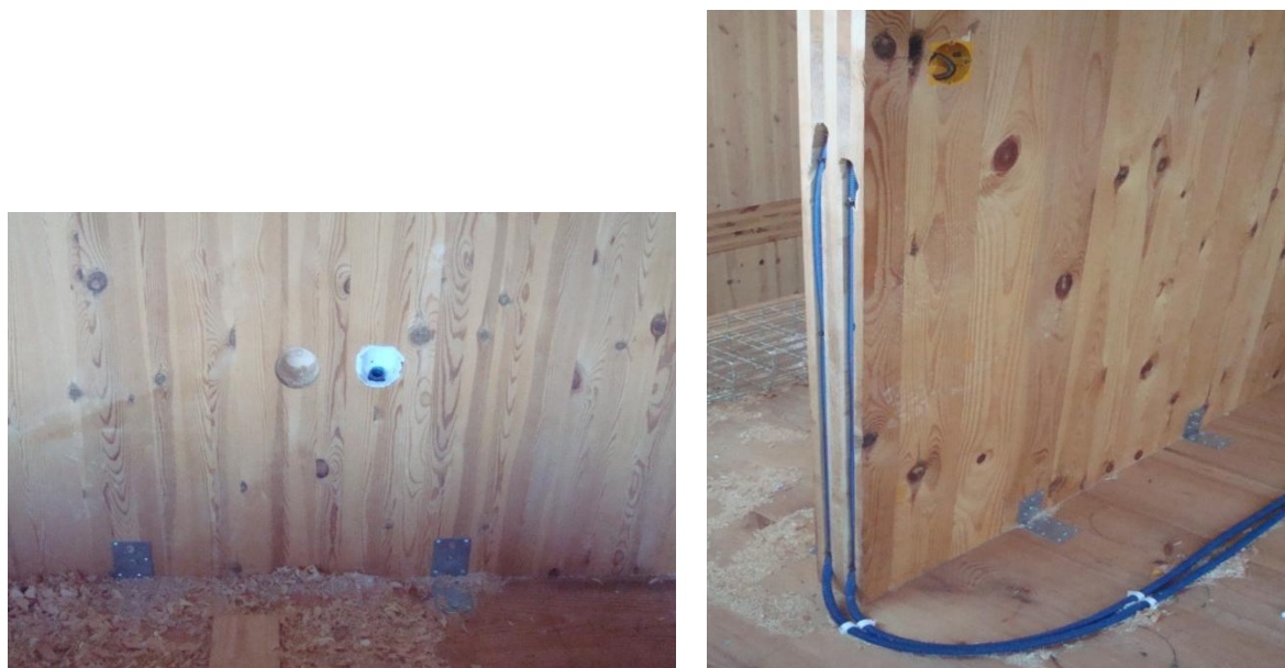
Figura 6 – Instalações elétricas em paredes com face à vista.
