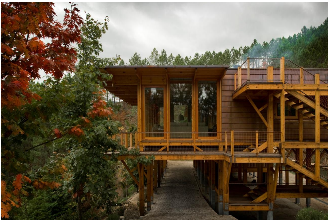
Figura 4 – Acesso automóvel pela cota inferior e escada de acesso à entrada.
