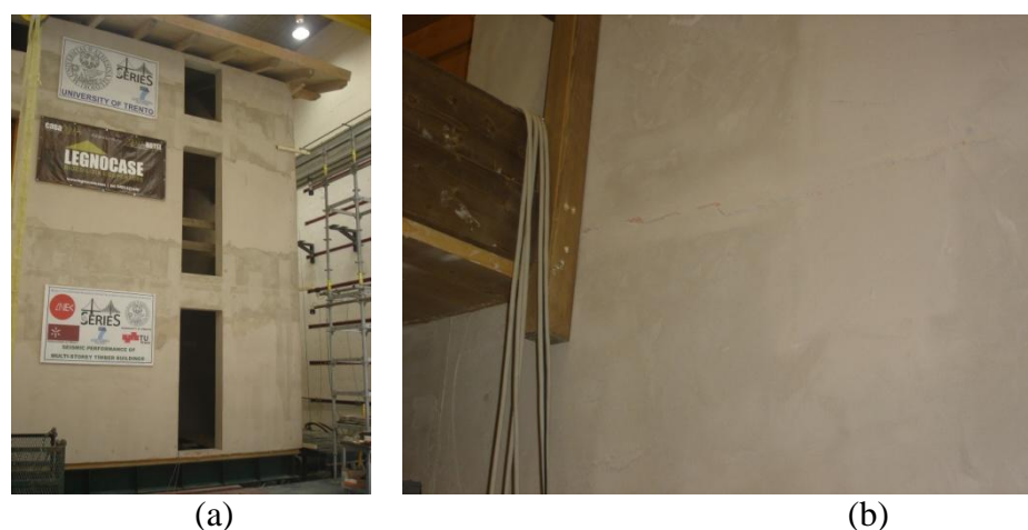
Figura 16 – Legnocase: (a) Edifício sobre a mesa; (b) Fissura ao nível da laje do primeiro piso detetada no final da campanha de ensaios.
