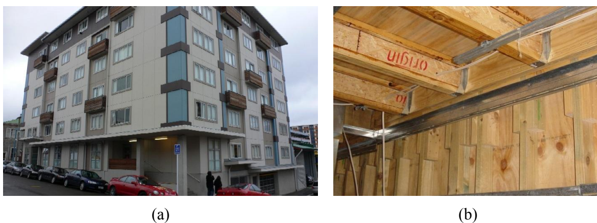
Figura 4 – Residência de estudantes na Nova Zelândia, 2004: (a) Imagem exterior; (b) Detalhe da estrutura [6].
