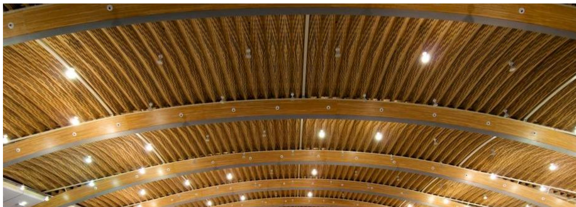
Figura 2 – Cobertura em madeira ( http://www.naturallywood.com/ ).
