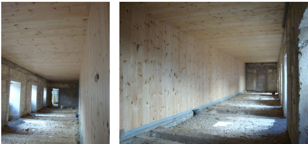
Figura 8 – Reabilitação de edifício.
