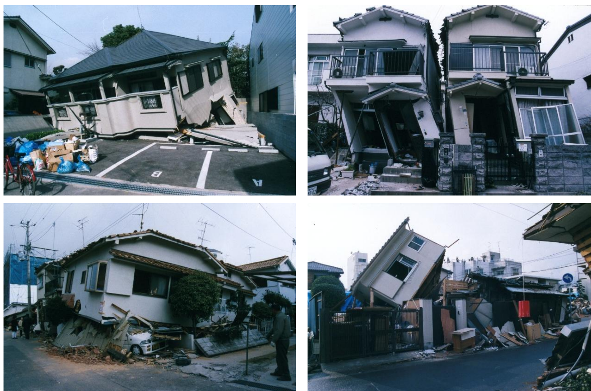
Figura 6 – Danos em casas de madeira no sismo de Kobe, Japão (1995) [8].
