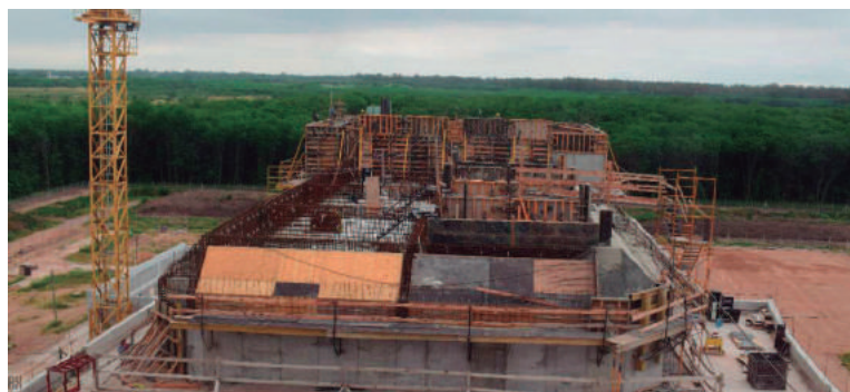
Reactor Multipropósito RA-10 en construcción en el Centro Atómico Ezeiza (Crédito CNEA, diciembre 2021)
