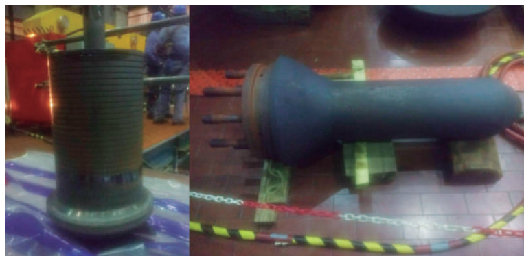
Desarme de la válvula de emergencia (izq.) y válvulas combinadas (der.) del turbogruppo
