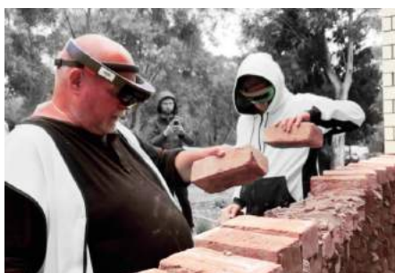
Fig.40. Albañiles utilizando RA para la construcción de un muro de ladrillo
