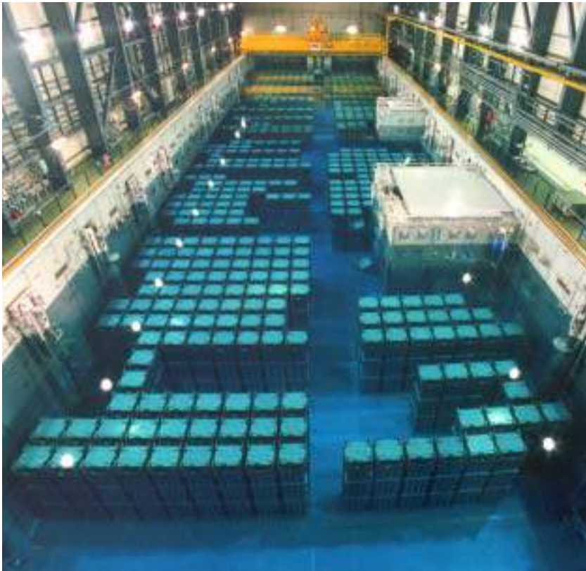
Piscina de almacenamiento de combustible gastado en una central nuclear
