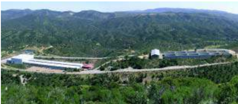
Vista aérea de las instalaciones de El Cabril
