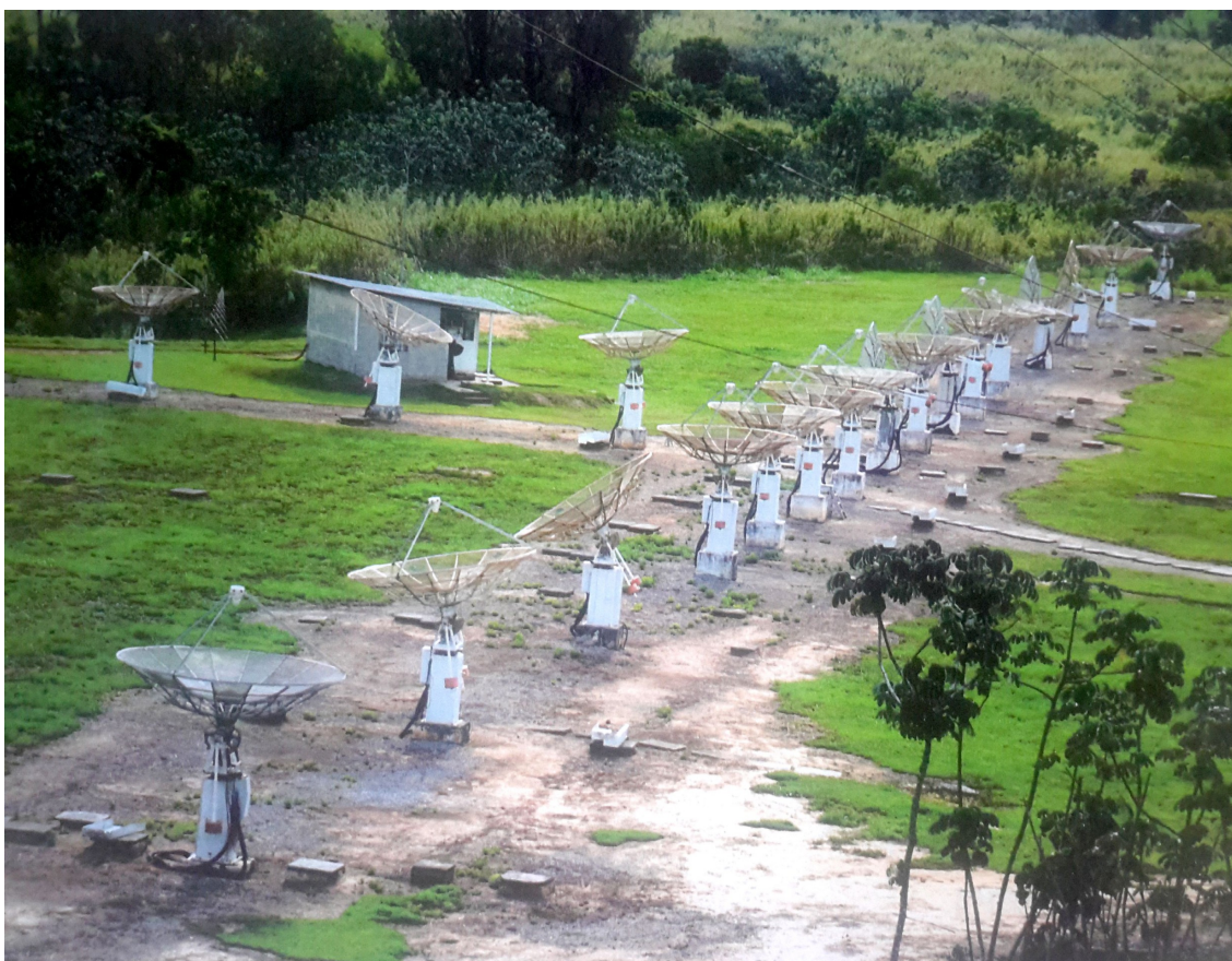
Figura 3: A disposição do arranjo central do Interferômetro Decimétrico Brasileiro (BDA) em sua fase II.
