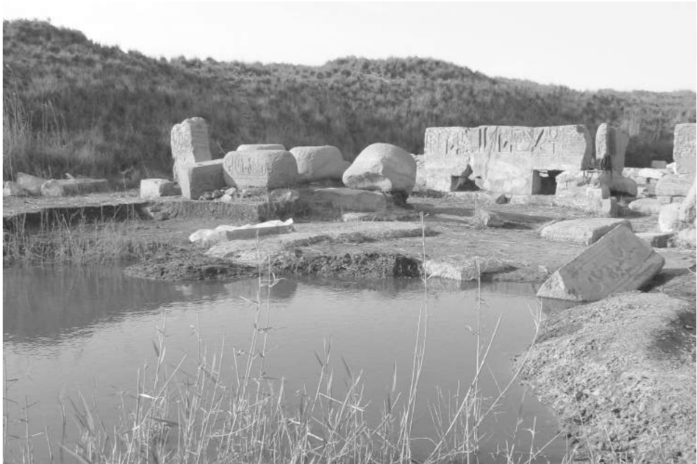
Fig. 1. Templo de Herishef -Heracleópolis Magna-. Inundación por subida del nivel freático.
