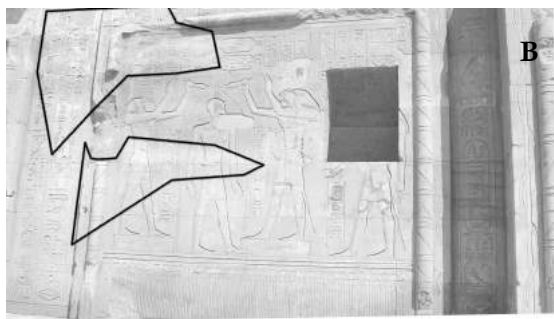
Figs. 2a, 2b. Efectos de las sales en el nilómetro y relieves. Templo de Kom Ombo.
