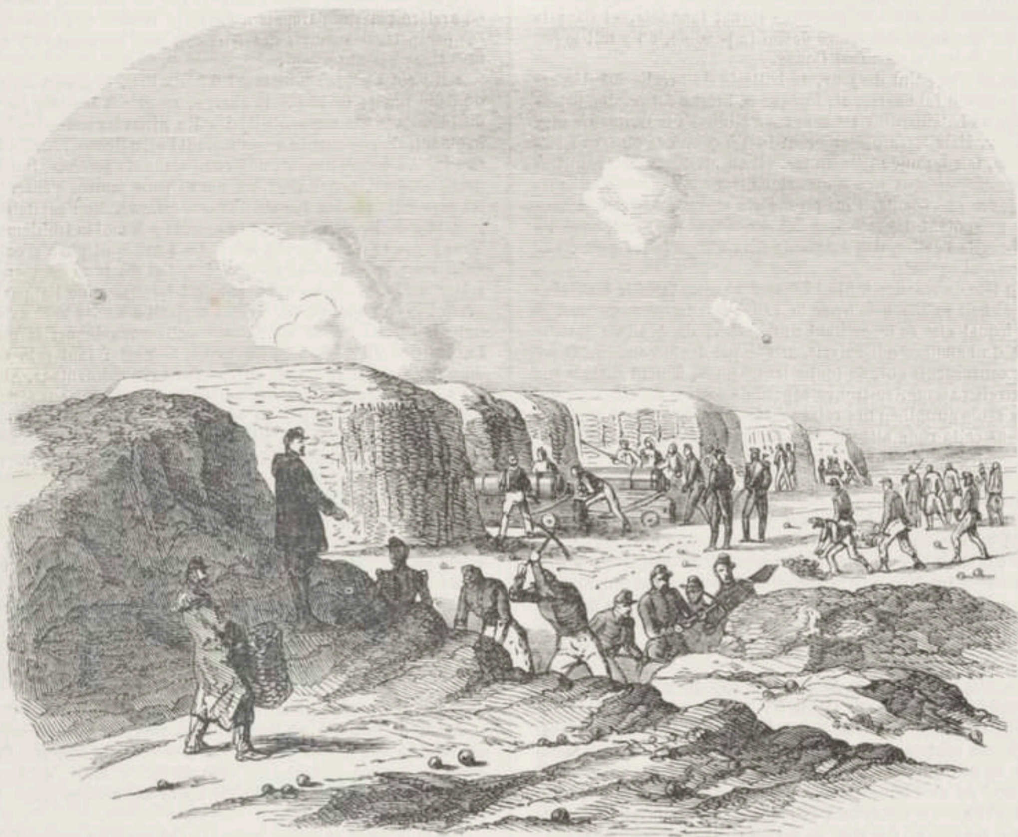
Ouverture de la tranchée,
