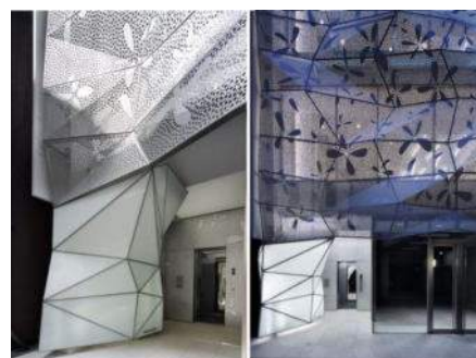
Figure 33: détails de la façade translucide (Source : www.archdaily.com )
