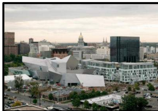
Figure 111: vue extérieure de musée Denver (Source : www.archdaily.com )
