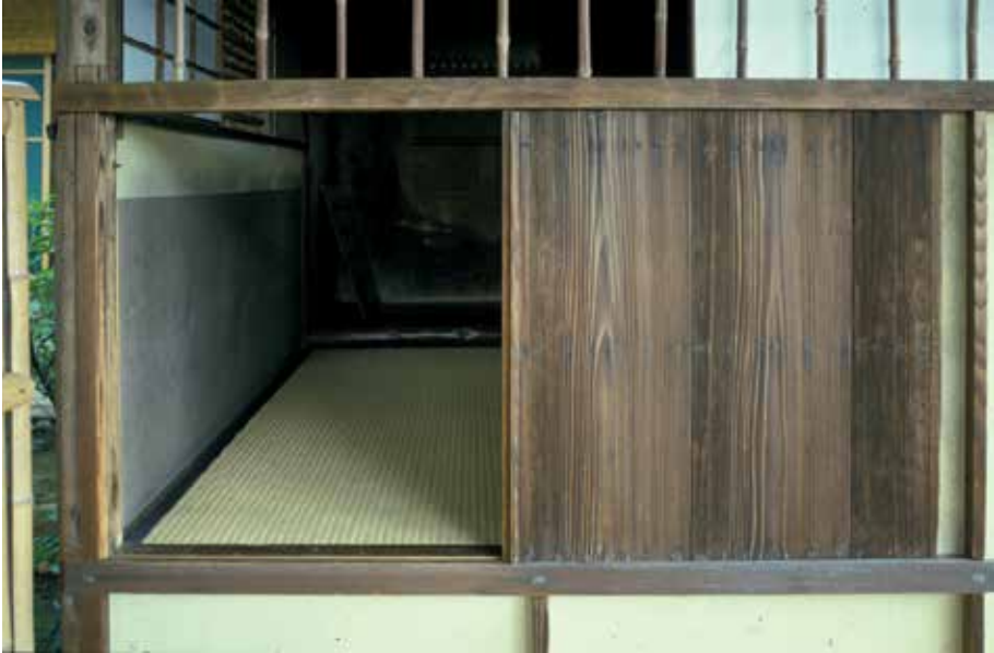
Fig. 5. Porte Nijiriguchi du Yodomi-no-Seki. Coulissant à l'extérieur de la face d'entrée, elle laisse entrevoir, dans le fond obscur, le Tokonoma.
