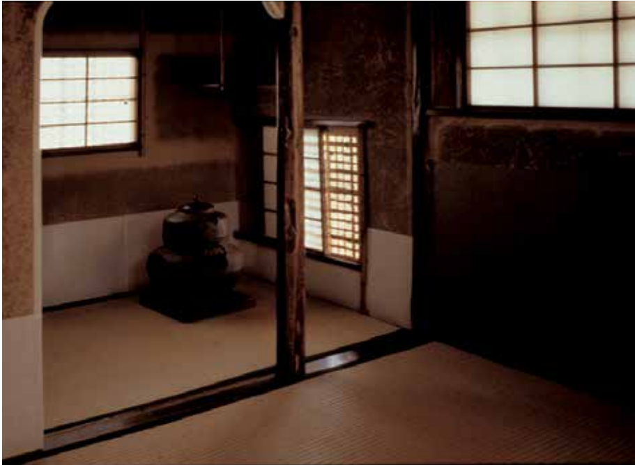
Fig. 9. Intérieur du Yodomi-no-Seki, vu de la place du premier invité assis près du tokonoma. Au centre, le poteau intérieur ou Nakabashira. À gauche, arête du mur intérieur ou Nakakabe.
