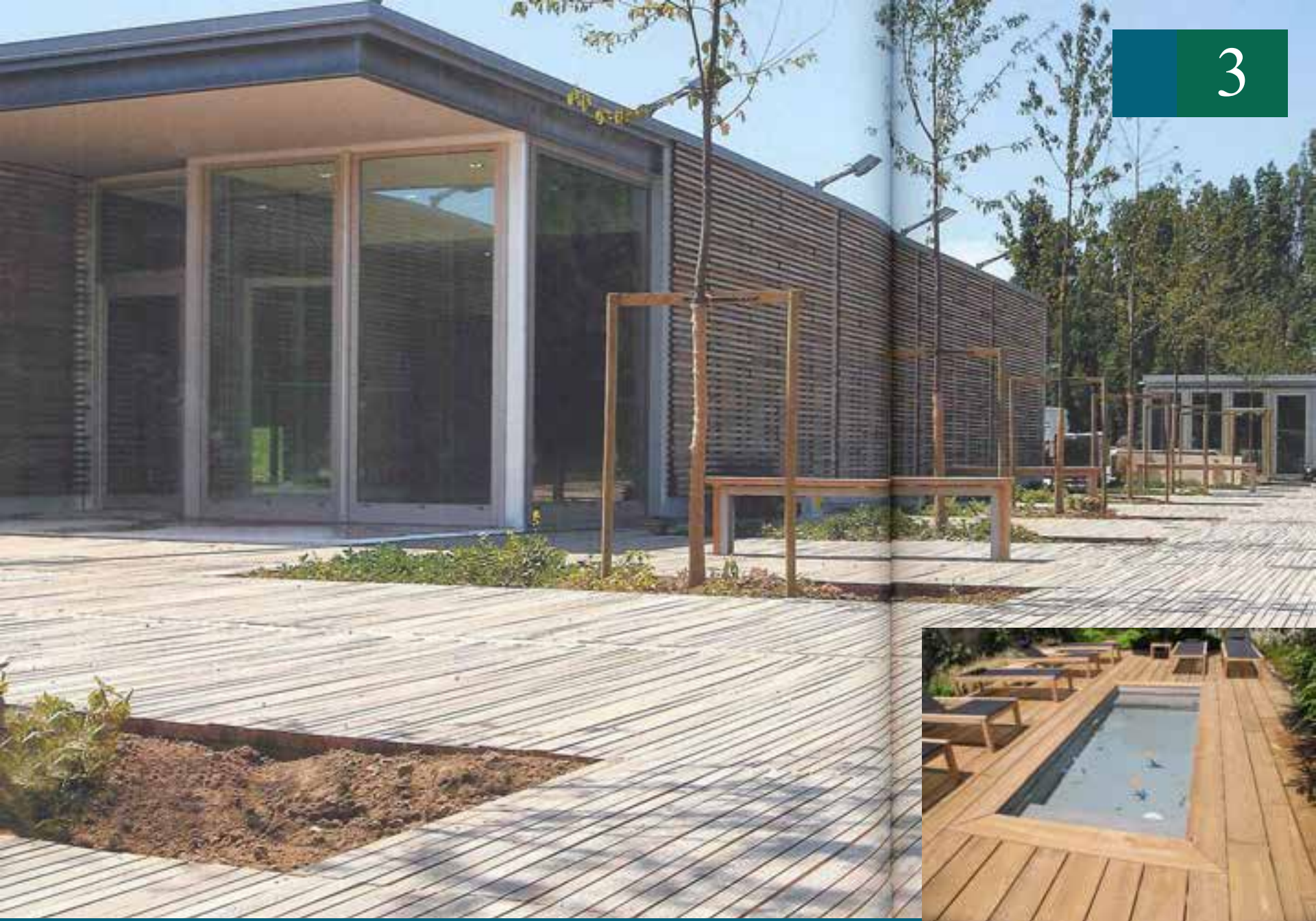
Éléments structurels : terrasse, palissades, piscine...
