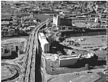
2000, L'autoroute Bonaventure entre le site de l'autostade et le Port de Montréal. Source: Ministère des Transports du Québec
