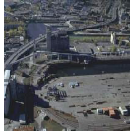
2000, Quai Bickerdike. Source : Ville de Montréal
