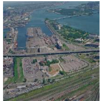
2000, Autostade. Source : Ville de Montréal
