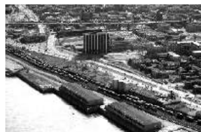
2000, Rampe du pont Jacques-Cartier au dessus du boulevard René-Lévesque et de la rue Notre-Dame. Source: Ministère des Transports du Québec
