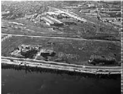
2000, Les abords du Technoparc. Source: Ministère des Transports du Québec
