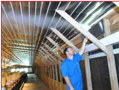
Figure 6.7 : utilisation d'un test de fumée pour déterminer si le flux d'air et la pression opérationnelle sont corrects.
