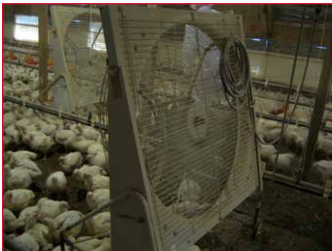
Figure 6.2 : ventilateur de circulation dans un bâtiment à ventilation naturelle.
