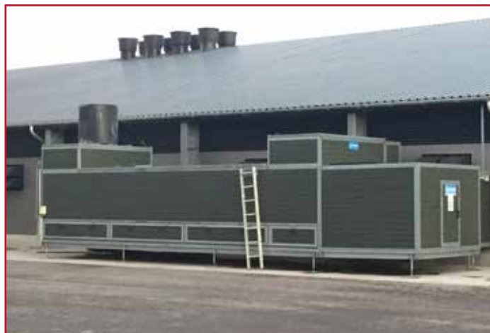
Figure 2.6 : exemple d'échangeur de chaleur.
