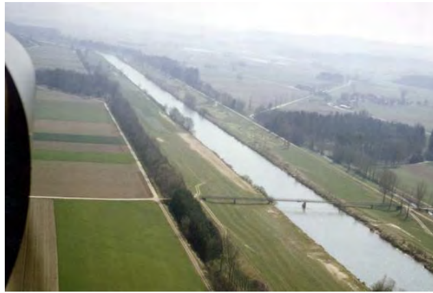
Figure 5.3 : beaucoup de cours d'eau de plaine ont été aménagés pour limiter leur expansion, lutter contre les crues, et assurer un certain débit dans la rivière. Ici la rivière Thur (Suisse) a été rectifiée au début du xx e siècle [Martin Jaeggi].
