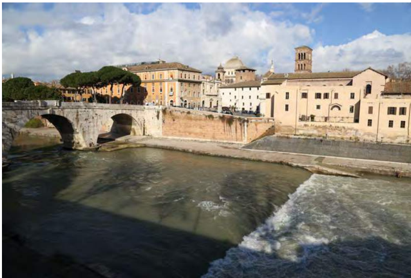
Figure 5.54 : seuil dénoyé sur le Tibre au niveau de l'île Tibérine à Rome. L'apparition d'eau blanche trahit la formation d'un petit ressaut à l'aval du seuil.
