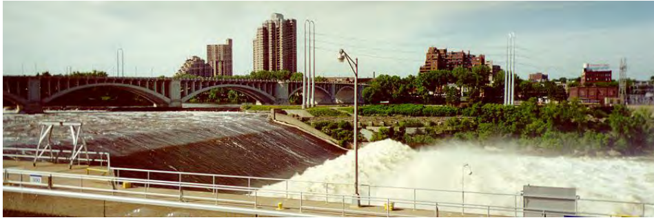
Figure 5.44 : ressaut hydraulique stationnaire sur le Mississippi au pied du seuil du Saint-Falls Laboratory de Minneapolis (États-Unis). Source : www.thefullwiki.org/Hydraulic_jump .
