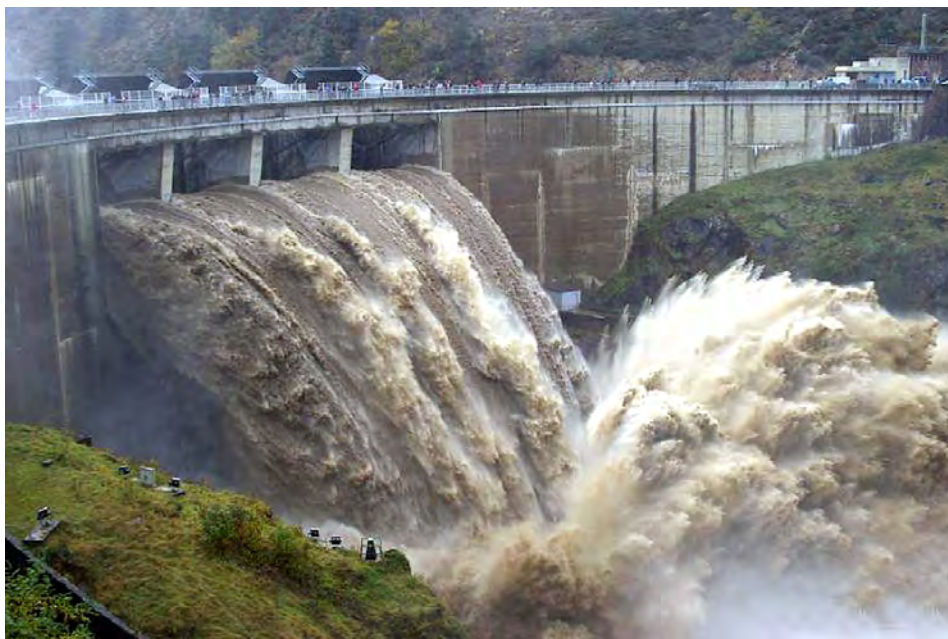
Figure 5.42 : crue de la Loire de novembre 2008 et passage de la crue au niveau de l'évacuateur de crue du barrage de Grangent. Source : DIREN.
