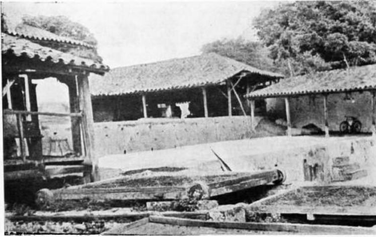
Les cuves de fermentation sont installées sous des hangars. Les amandes sont ensuite mises à sécher en couches minces sur des chariots sur rails, rentrés sous des abris la nuit et en cas de pluie.
