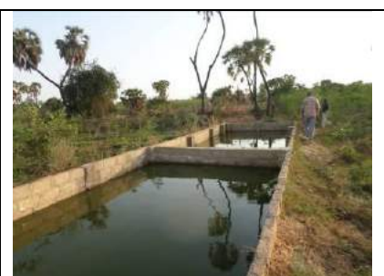
Bassins en parpaings. Compte tenu du coût, le promoteur est passé à l'utilisation de bâches.
