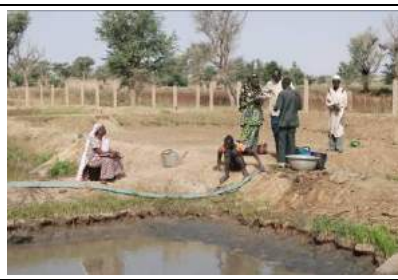
Bassins en terre à Kollo, touchés par l'inondation de 2012. Le promoteur construit une clôture pour placer un grillage fin capable de retenir les poissons
