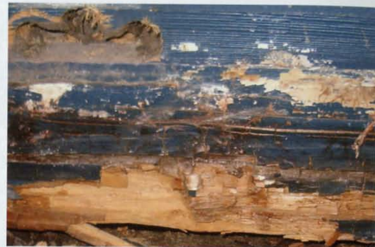
La pièce de bois attaquée par le mэрule se désagrège sous la forme d'une « pourriture cubique » caractéristique.
