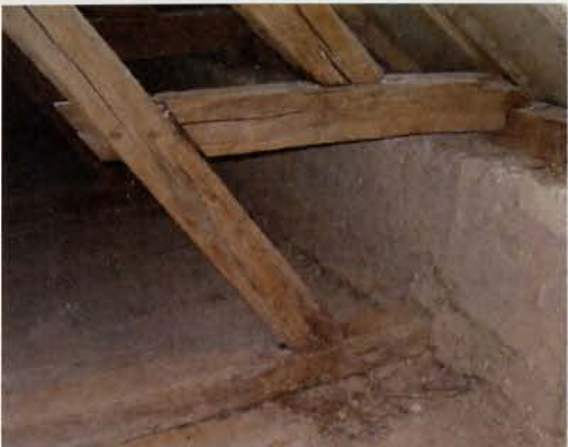
Le pourrissement de l'extrémité inférieure de cette jambe de force assemblée à l'entrait bas semble indiquer un désordre de toiture avec cheminement de l'eau le long des bois.
