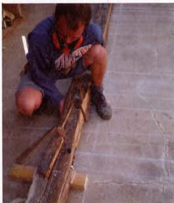
Le charpentier contrôle la ligne de niveau sur la pièce de bois mise sur épure, par une plumée de dévers.
