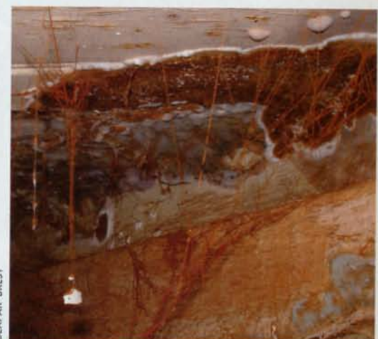
La pièce de bois attaquée par le mэрule se désagrège sous la forme d'une « pourriture cubique » caractéristique.
