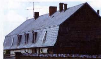
L'usage d'une charpente «à la Mansard» a permis l'utilisation optimale du volume des combles de cette maison normande.
