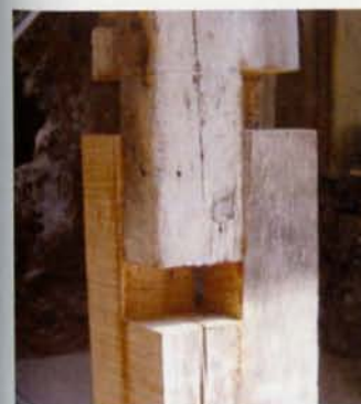
Principe de l'enture à bois debout ; les pièces s'ajustent sans jeu.
