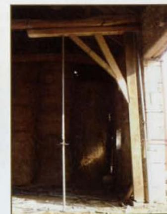
1. Un Tirfor® est utilisé pour «ramener» au plus près les deux éléments de l'entrait rompu.
