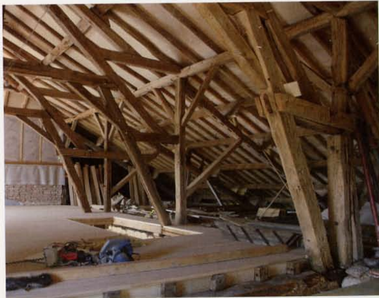
Cette charpente fait l'objet d'une restauration complète dans le cadre d'un aménagement de combles.
