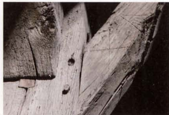
Les marques de charpente sont toujours positionnées en pied de pièce.
