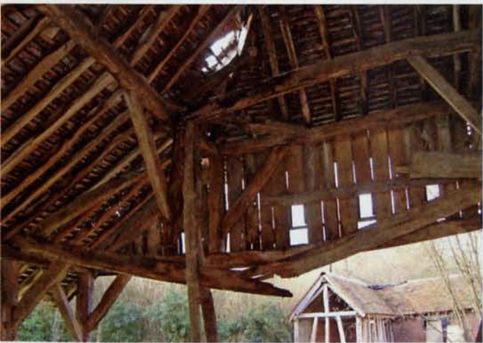
Le pourrissement de l'extrémité inférieure de cette jambe de force assemblée à l'entrait bas semble indiquer un désordre de toiture avec cheminement de l'eau le long des bois.
