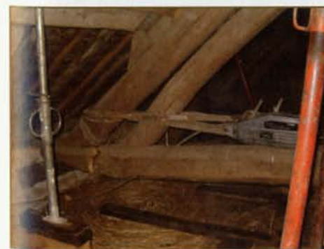
1. Un Tirfor® est utilisé pour «ramener» au plus près les deux éléments de l'entrait rompu.
