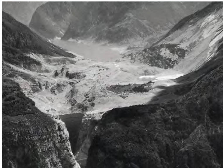
Figure 3.3 : barrage du Vajont après le mouvement de terrain du 9 octobre 1963.
