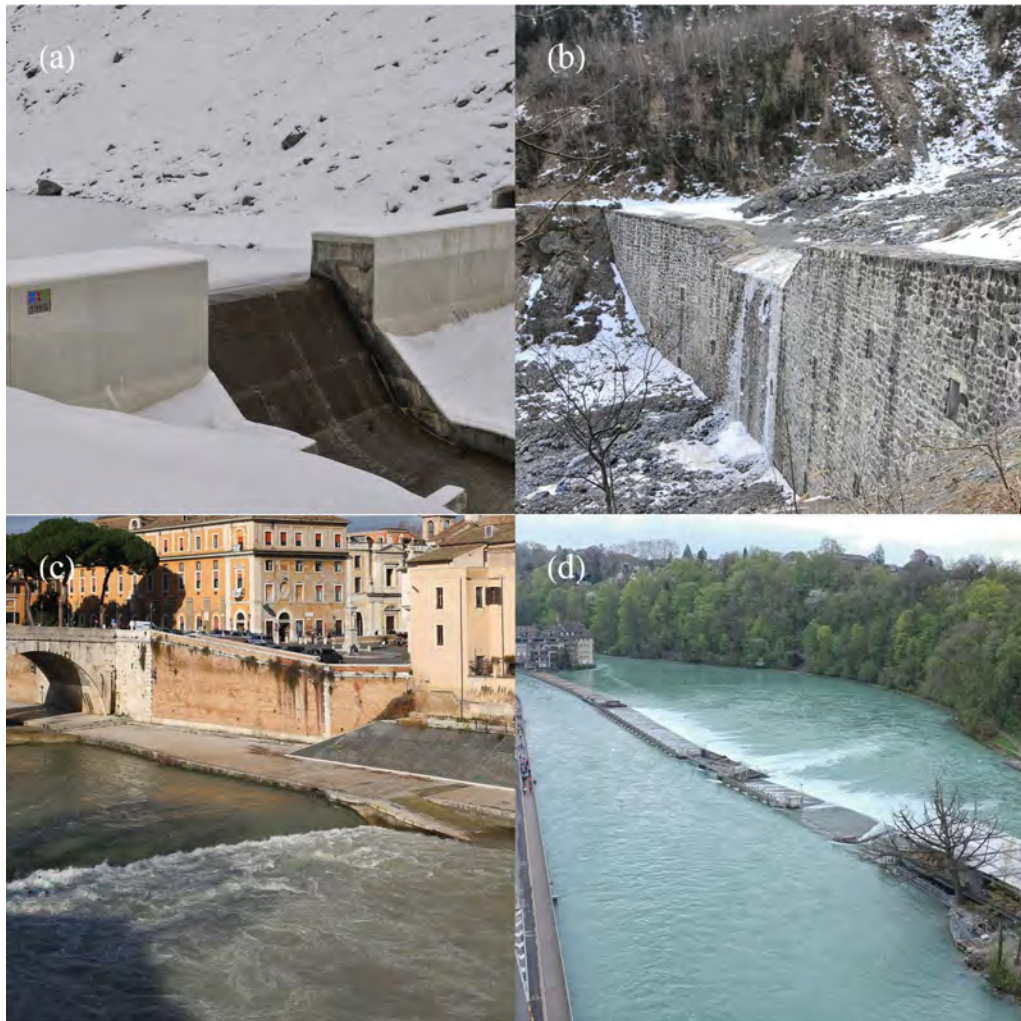
Figure 1.10 : différents types de seuil et déversoir. (a) Déversoir du lac de Louvie au-dessus de Fionnay (VS); (b) seuil de confortement du lit du torrent de Saint-Barthélemy au-dessus de Mex (VS); seuil noyé sur le Tibre à Rome (Italie); (d) déversoir latéral sur l'Aar à Berne.
