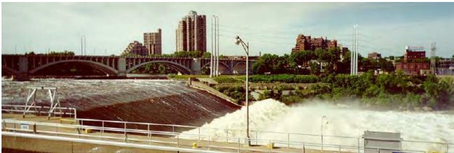
Figure 1.3 : ressaut hydraulique stationnaire sur le Mississippi au pied du seuil du Saint-Falls Laboratory de Minneapolis (États-Unis). Source: www.thefullwiki.org/Hydraulic_jump .
