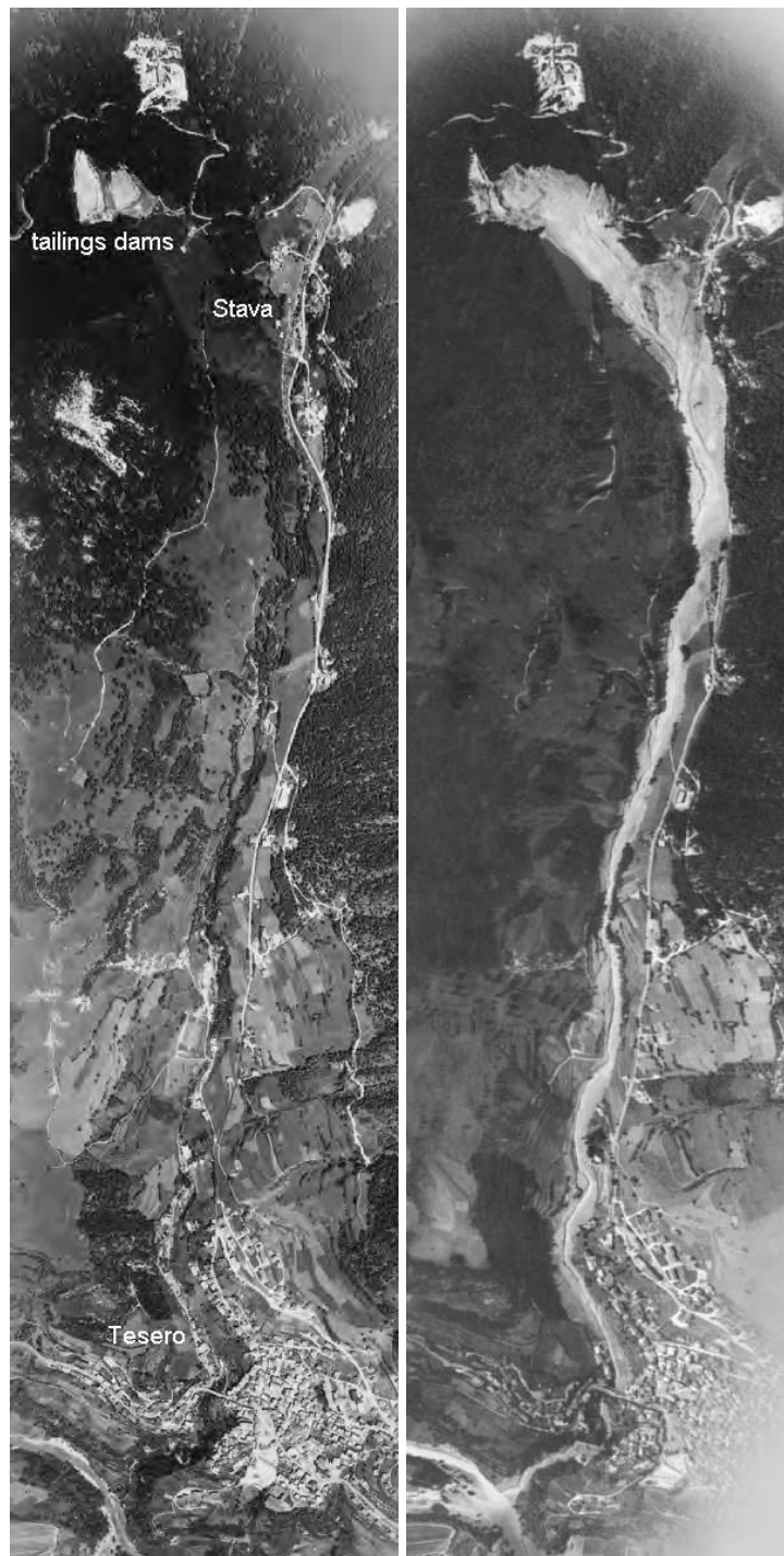
Figure 3.16 : vue du Val di Stava avant et après la catastrophe. Source : www.wise-uranium.org .
