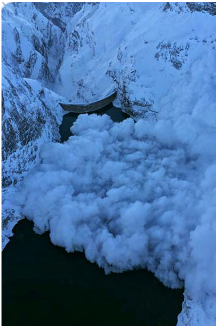
Figure 4.8 : avalanche en aérosol déclenchée artificiellement atteignant le lac de Linth-Limmeren (Linthal, GL). Avec une revanche de 40 m, le barrage est protégé contre les vagues d'impulsion. Source : R. Stüssi.
