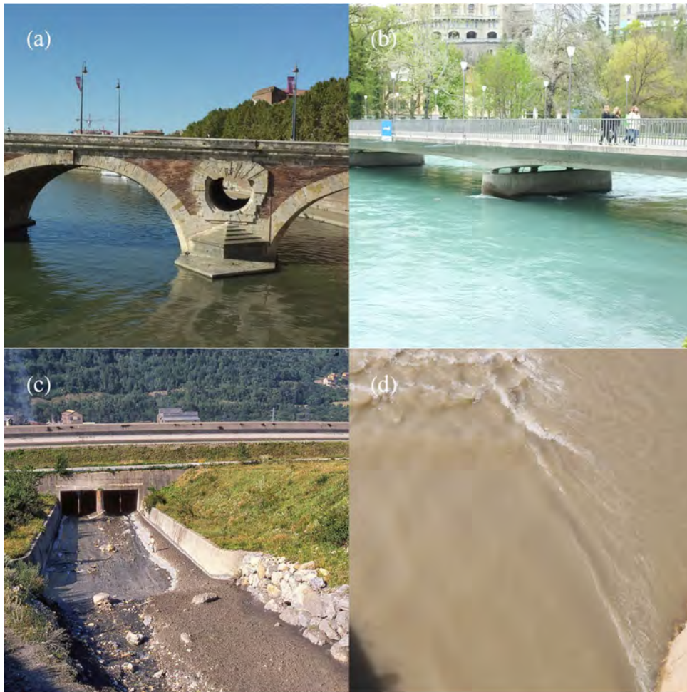
Figure 1.12 : différents types de passages couverts. (a) pont sur la Garonne à Toulouse (France). On notera les ouvertures aménagées au-dessus des piles du pont pour laisser transiter l'eau lors des crues; (b) passerelle sur l'Aar à Berne; (c) dalot sous l'autoroute A43 en Maurienne (France); (d) ressaut au passage entre deux piles du pont de Cordoue enjambant le Guadalquivir (Espagne).
