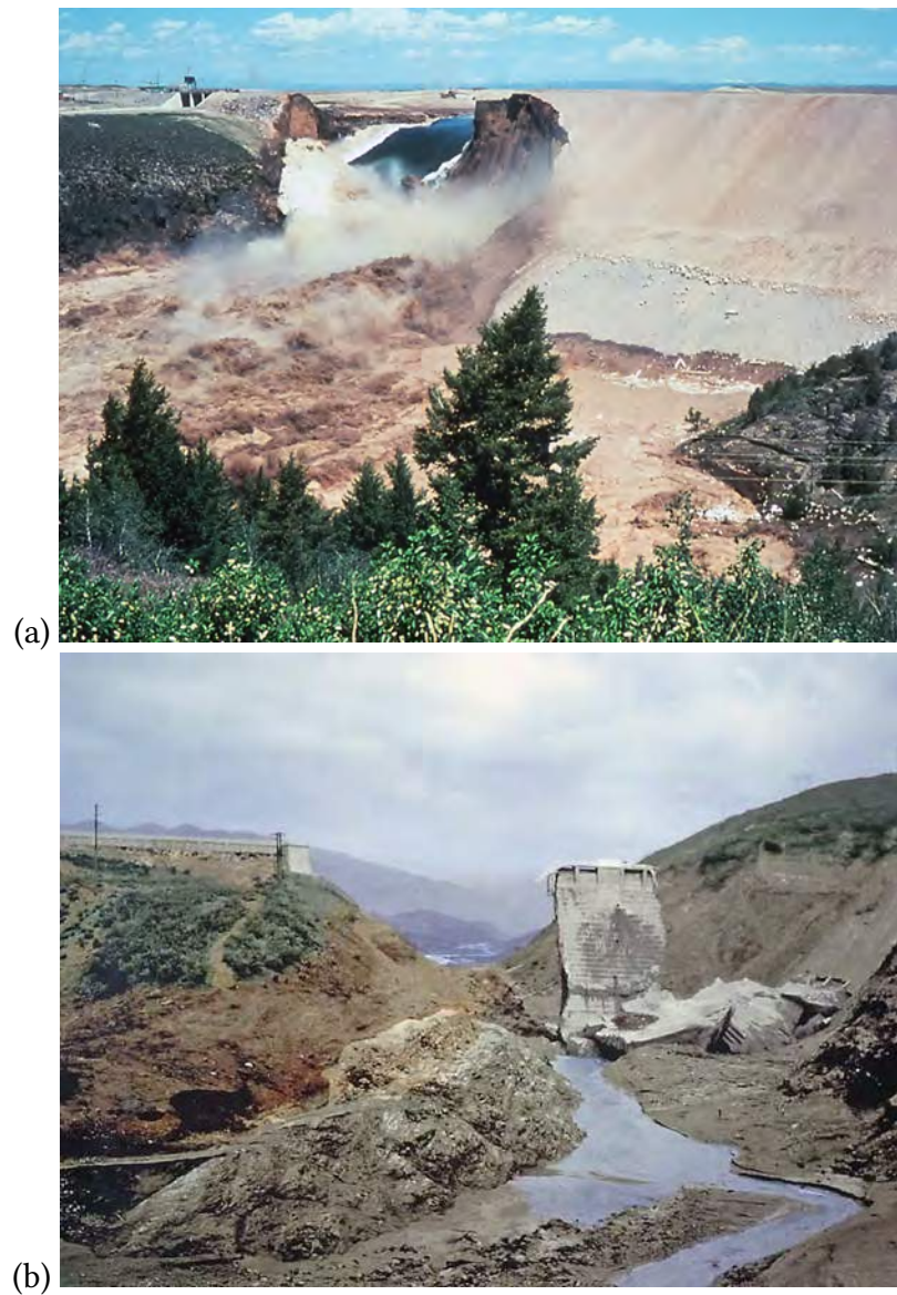
Figure 3.8 : rupture du barrage en terre de Teton (Idaho) en 1976. (b) Ruines du barrage de Saint-Francis (Californie) en 1928. [DR].
