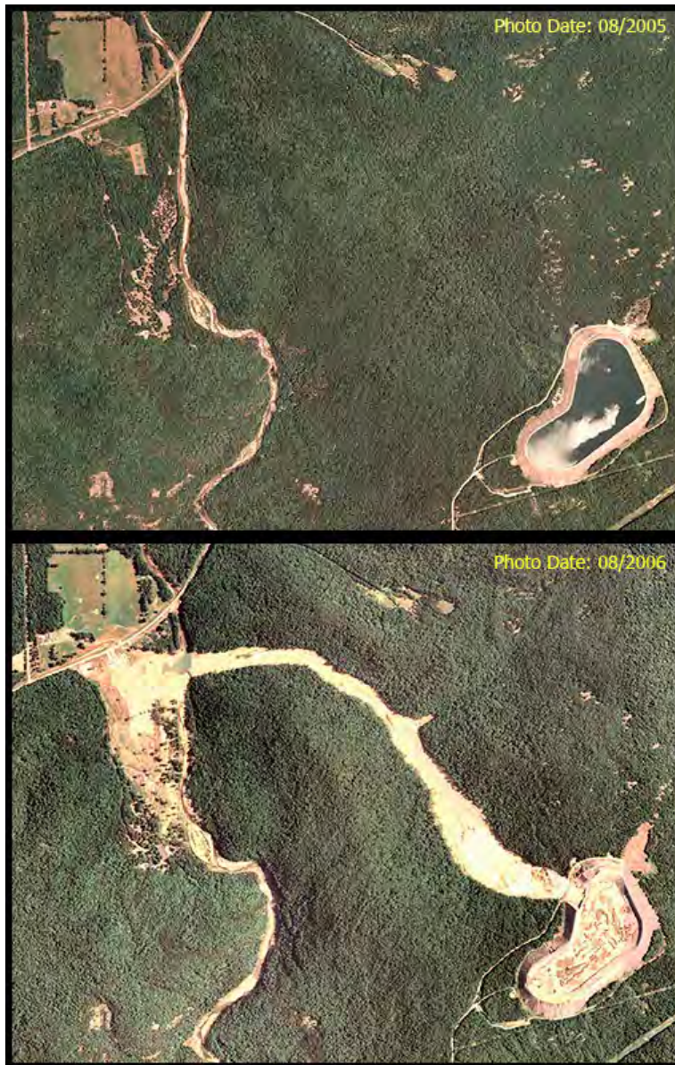
Figure 3.1 : rupture du barrage de Taum Sauk dans le Missouri (États-Unis) en décembre 2005.
