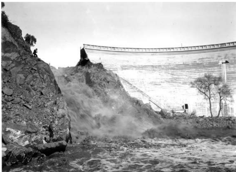
Figure 3.5 : érosion des berges contre lesquelles s'appuyait le barrage de Sweetwater en 1916.
