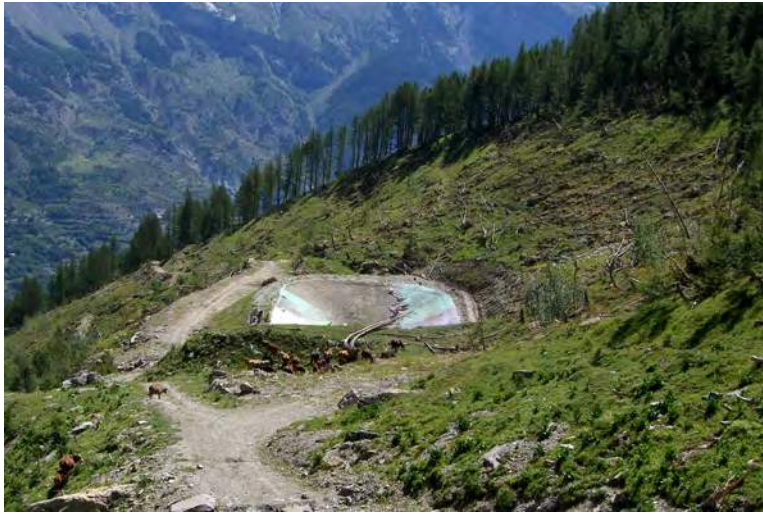
Figure 3.9 : avalanche du 9 mars 2006 détruisant la retenue de la station de Pelvoux (Hautes-Alpes, France) situé dans le bassin-versant de la Bouisse. Source : (Evette et al. , 2011).
