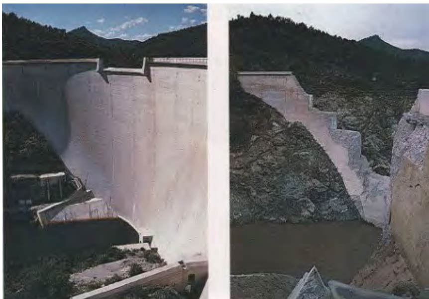
Figure 3.7 : barrage de Malpasset. [DR].
