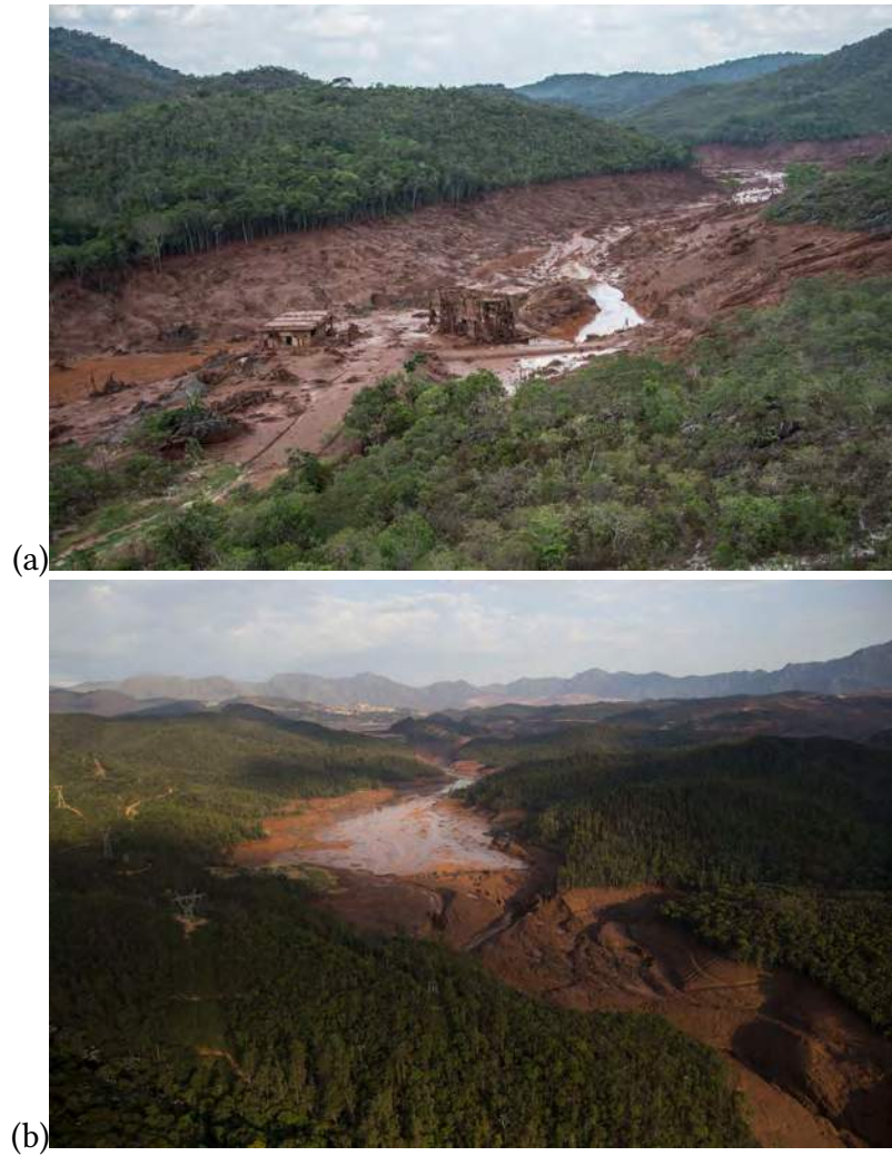
Figure 3.14 : le 5 novembre 2015, deux bassins de décantation miniers cèdent près de la ville de Bento Rodrigues (Brésil) causant victimes et pollution dans toute la vallée.
