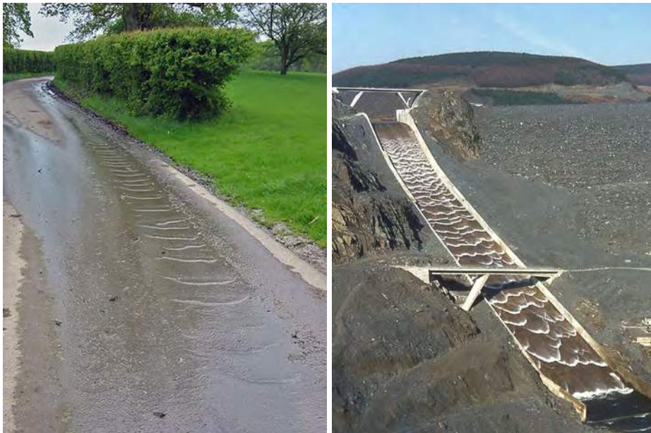
Figure 4.44 : train d'ondes dans un évacuateur de crue et sur la chaussée après une chute de pluie. Source http://people.seas.harvard.edu/shreyas/Research.html
