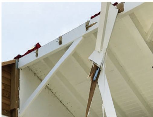
Figure 5 : Mauvais assemblage
