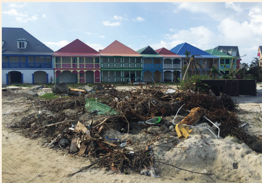
Figure 1 : Charpentes en site exposé ayant résisté
