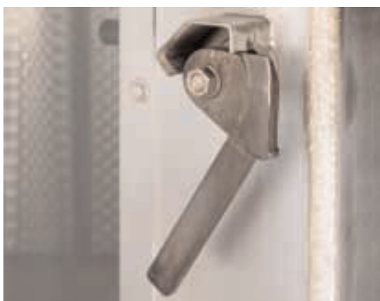
Figure 21 Porte avec système de déverrouillage permettant de quitter le local de cuisson en tout temps.
