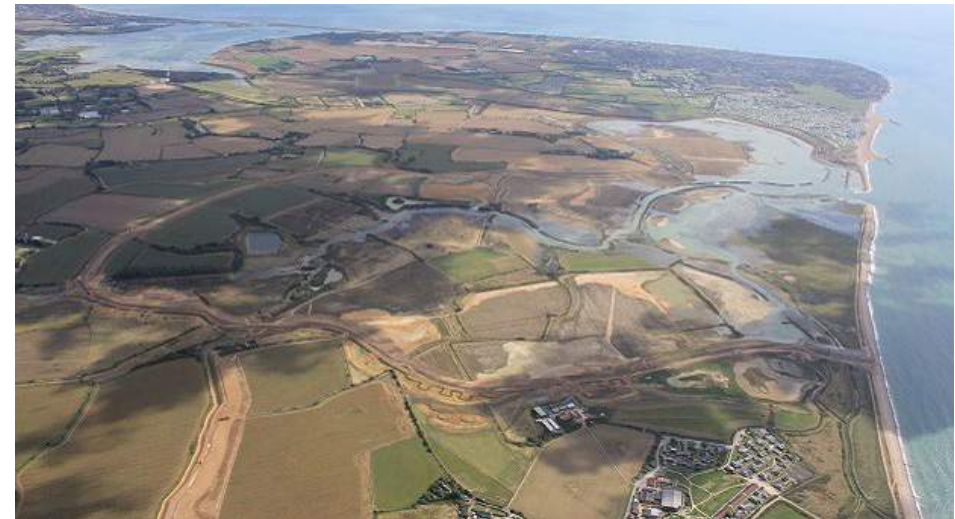
Figure 9 Une vue aérienne du projet Medmerry. Des acteurs locaux ont inspecté avec l'Agence pour l'environnement une brèche de 110 m de large réalisée dans la berge faite de galets pour permettre aux eaux de marée de s'écouler et créer une nouvelle zone d'habitat intertidal de 183 ha (projet de Medmerry). © Environmental Agency. Contient des informations du secteur public sous licence Open Government License v3.0.
