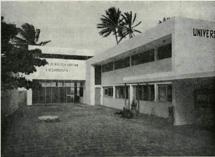
Fig. 1. — La cour intérieure de la station.
