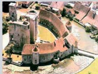
3- CHÂTEAU FORT À SAGONNE
