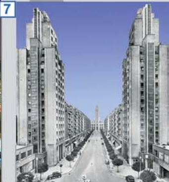
8- TOUR D'ORIENTATION DE GRENOBLE, 1925, arch. : A. PERRET
