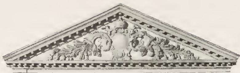
Façon-roy de La Courbe, de Sturti — Ancien Grenier de l'Abbaye, Berlaud de La Vaux, architecte (1722).
