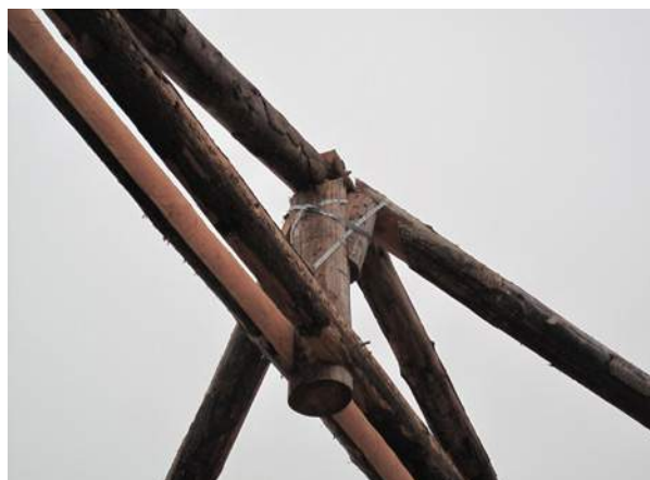
▲ Les demi-charpentes reposent sur deux corbeaux et sont fixées par une bande perforée.
