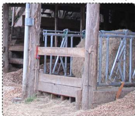
Poteaux encastrés dans une semelle filante (renfort comadis)
