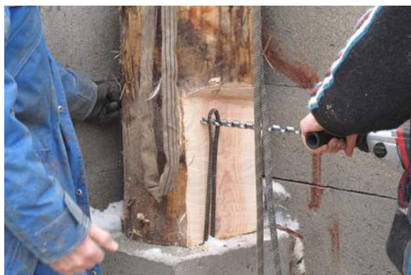
△ Ancrage de la charpente aux pieds.
