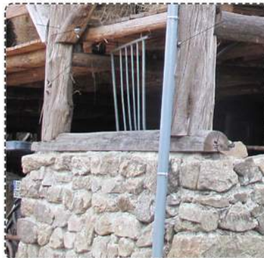
Poteaux sur semelle d'assise
