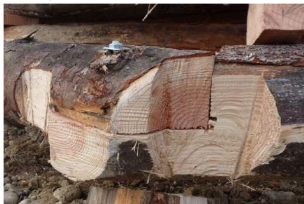
▲ Encoches sur les arbalétriers destinées à recevoir les pannes faitières.
