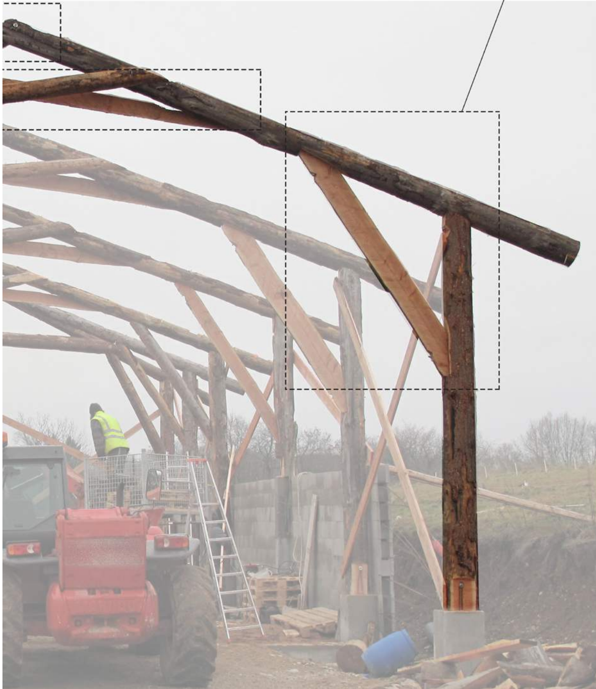
Assemblage avec tige filetée
