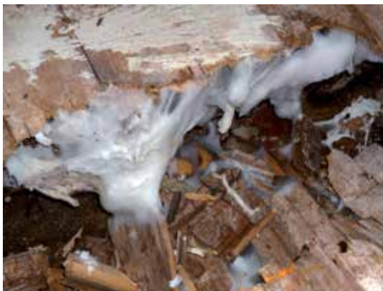
Infestations sur charpentes et planchers en bois
