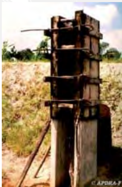
Photo I. Moule et moines (Guinée). À gauche : Le 1er étage et le moule ; À droite : Mise en place du 2ème étage [© APDRA-F] (CIRAD).
