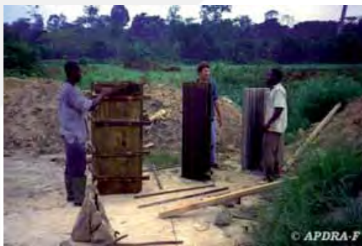
Photo I. Moule et moines (Guinée). À gauche : Le 1er étage et le moule ; À droite : Mise en place du 2ème étage [© APDRA-F] (CIRAD).
