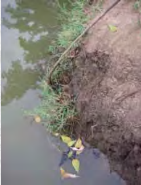
Photo F. Digues. À gauche : Pente mal réalisée qui s'érode (RDC)[© Y. Fermon] ; À droite : Construction (Côte d'Ivoire) [© APDRA-F] (CIRAD).
