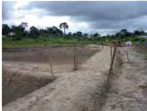
Photo E. Piquets lors de la construction des digues (Libéria) [© Y. Fermon].
