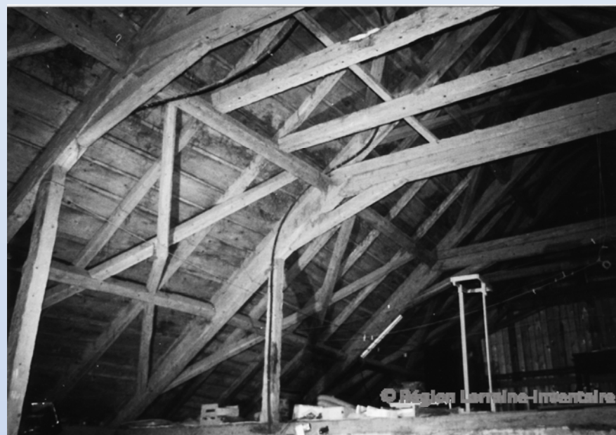
Charpente à entrain retroussé et blochets sur poteau, 88-Plainfaing.
