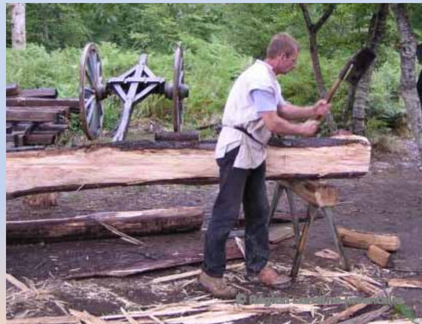
Équarrissage à la doloire ou « épaule de mouton » (89-Guédelon, château).
