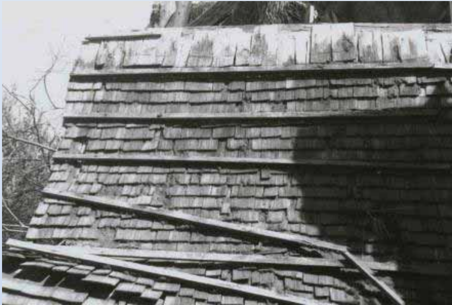
88-Mandray, pan de toiture couvert de bardeaux puis de tuiles sur lattis.
