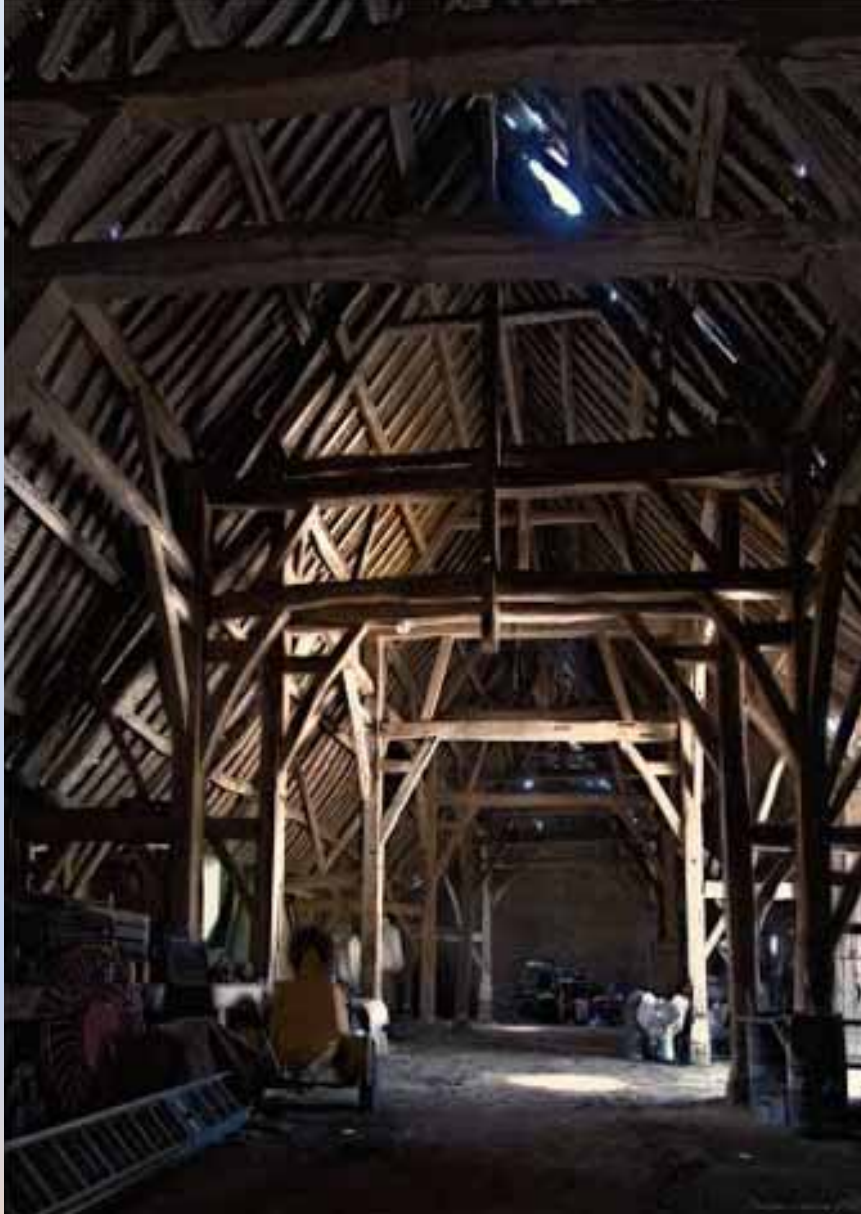
Charpente de grange dîmière à 3 vaisseaux, 15 e siècle, 27-Daubeuf-la-Campagne.
