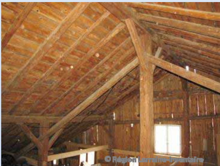
Rampants et aisseliers, 88-Mandray.
