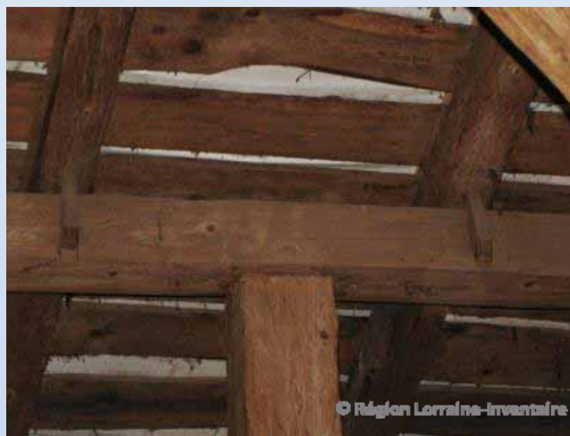
et cheville d'arrêt des chevrons, 88-Taintrux.
