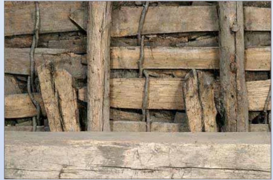
54-Loromontzey, voligeage retenu par des liens de noisetier.
