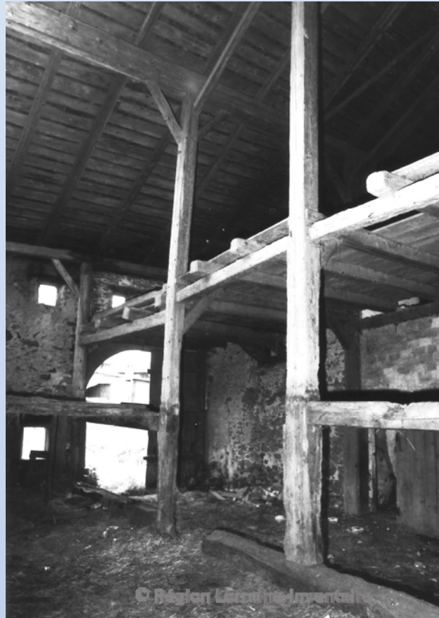
Sablère au sol, 88-Entre-Deux-Eaux
