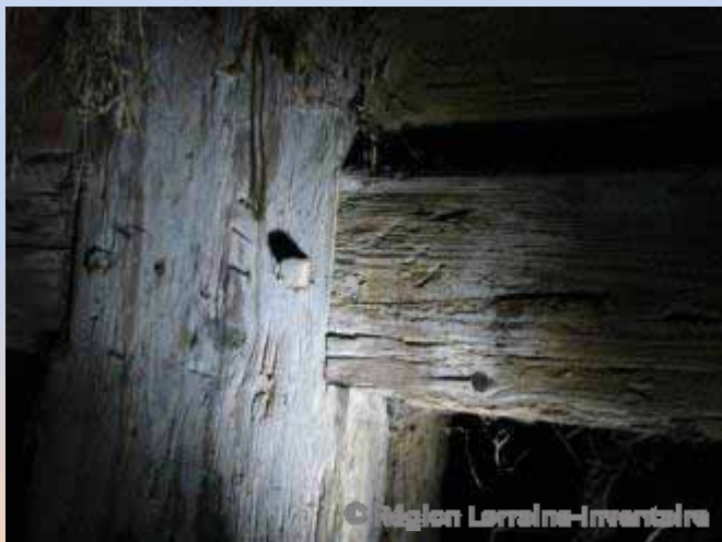
Marque d'assemblage, 18 e siècle, 88-Mandray.
