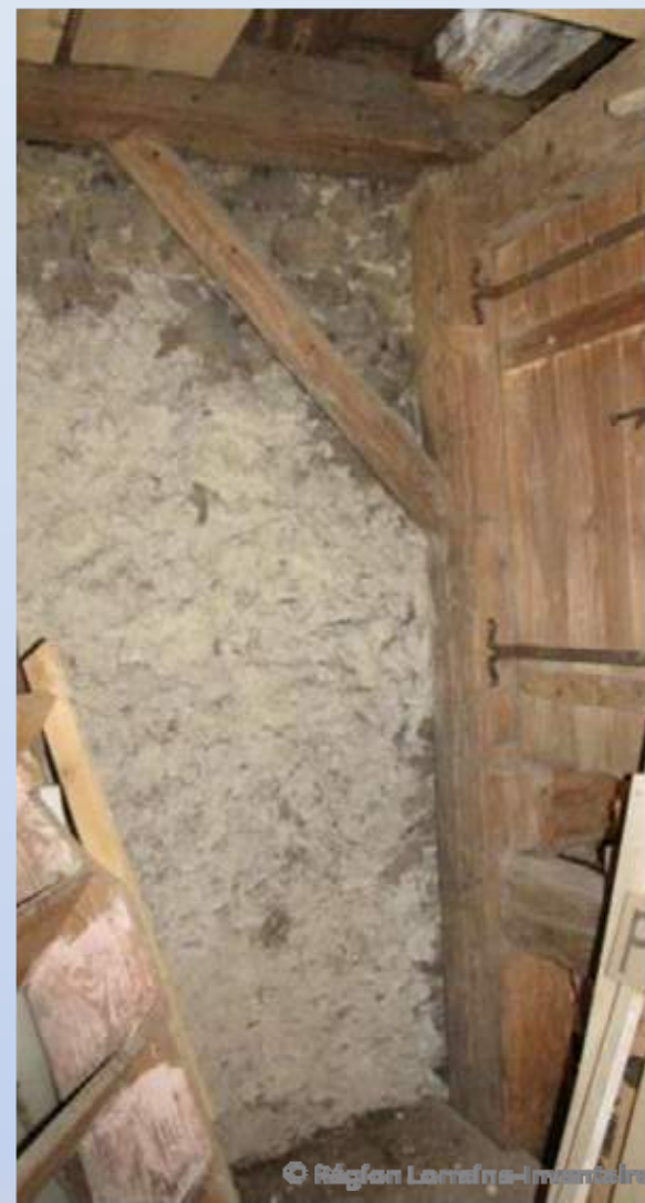
Homme-debout le long du mur gouttereau, 88-Mandray.
