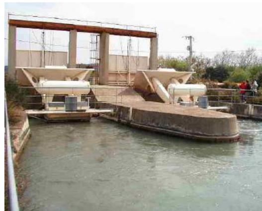
FIGURE 4.42 – Vannes à niveau aval constant (AVIS) – Lamanon
