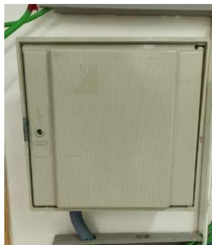
En cas de raccordement aérien, le BPG peut être installé en montage apparent, à une hauteur comprise entre 3 et 4 m du sol.
