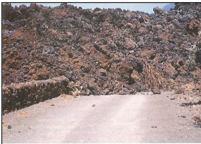
Fig. nº 5.2.4 - Chã das Caldeiras. Via de acesso às povoações de Chã das Caldeiras interrompida pelas lavas
