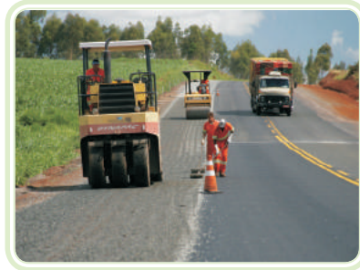
Figura 2.6: Exemplo de construção de estradas
