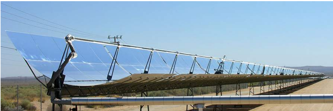
FIGURA 2.11 Los colectores cilindro-parabólicos se utilizan para generar electricidad en el sur de California (crédito: "kjkolb"/Wikimedia Commons)
