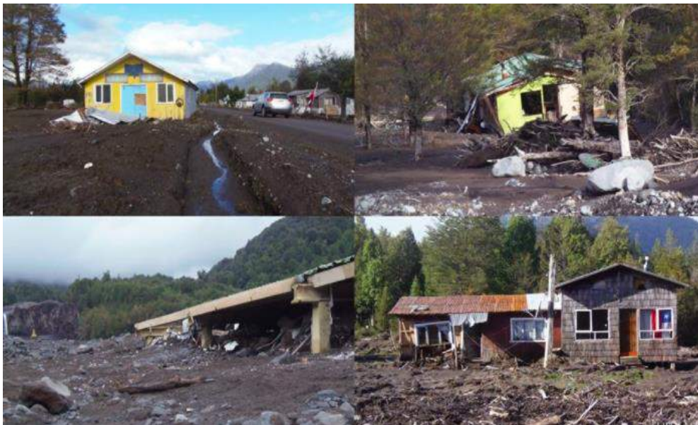
Fig. 31: Infraestructuras destruidas por el lahar primario generado post erupción del volcán Calbuco, Chile.
