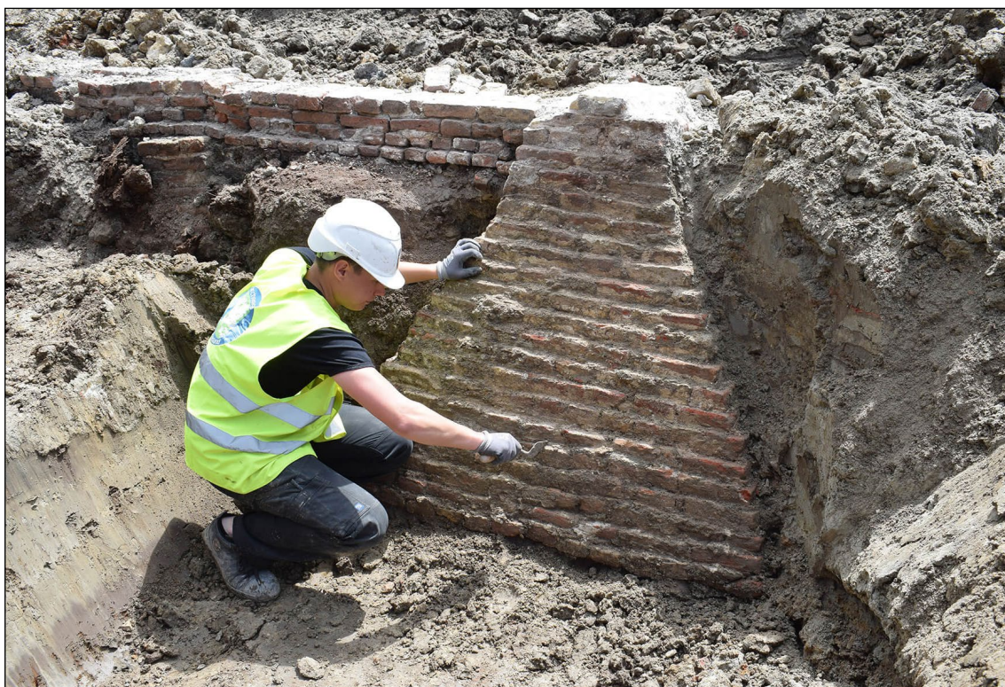
Afb. 55. Vierkantpoer van een Westfriesse stolpboerderij uit Schellinkhout. De versnijdende zool zorgt voor genoeg draagkracht om het vierkant te dragen.
