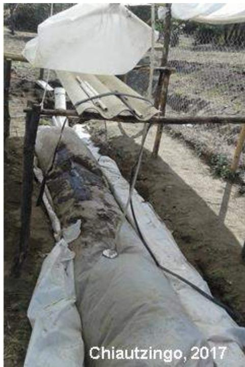
**Fig. 2** Biodigestor de bajo costo de flujo continuo (régimen mesofílico)
