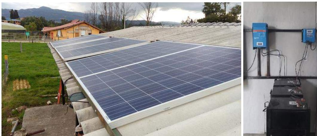
Figura 3. Implementación sistema de energía, paneles solares, Inversor, regulador y baterías
